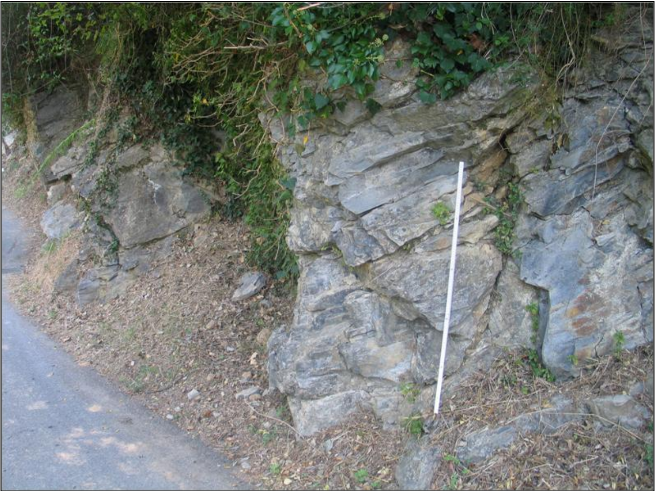
Foto 2: Affioramento del rilievo geologico RG9
