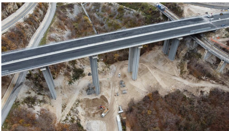
Figura 8-2 Area al di sotto di un tratto del viadotto attuale
