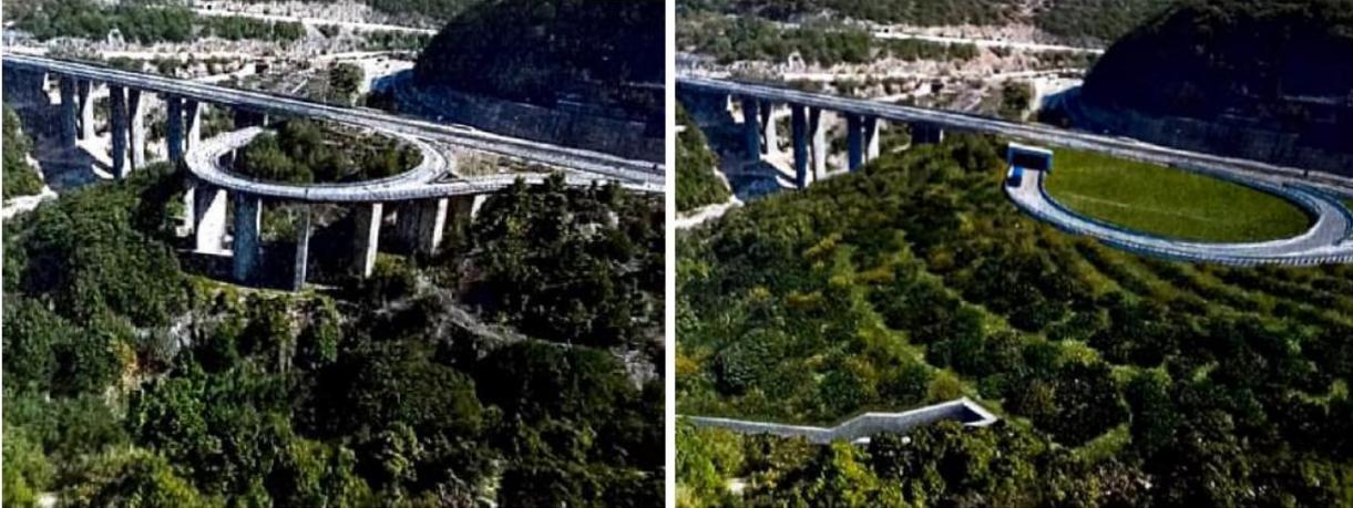
*Figura 6-1 Fotosimulazione della soluzione in rilevato*
