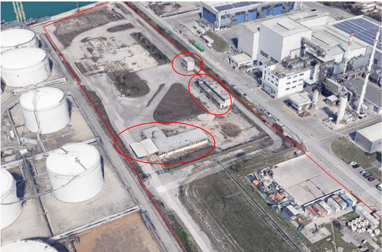
Fig. 1 : vista sud ovest dell'area di cantiere, in rosso sono cerchiati gli edifici oggetto di futura demolizione
