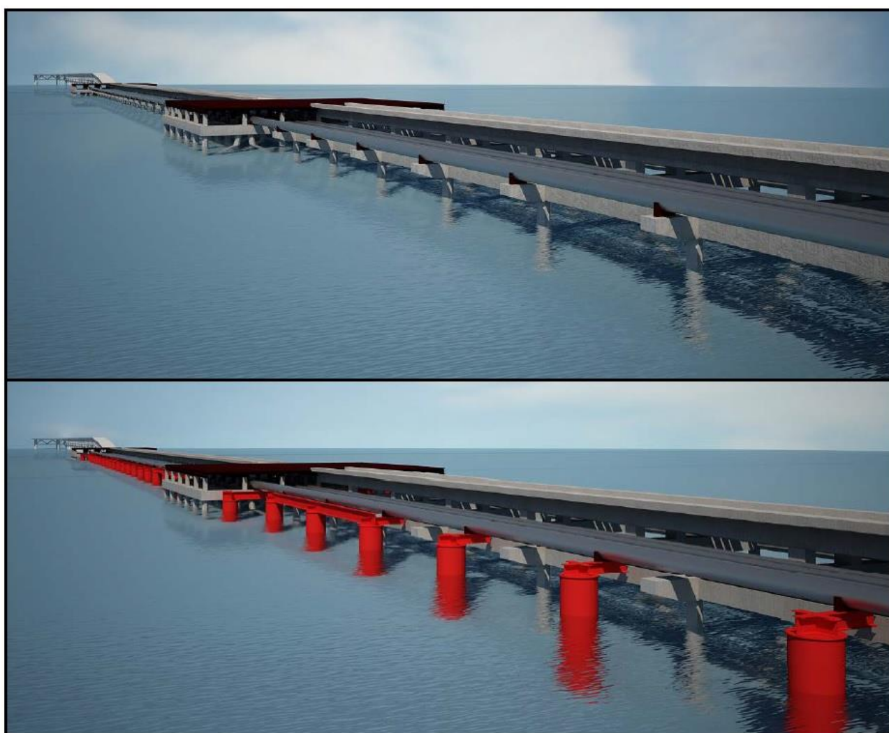
Fig.1 – Ricostruzione grafica del Petroli Raffineria ENI di Taranto prima e dopo i lavori
