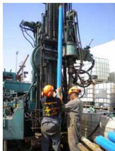
Posa piezometro in PVC da 4" al termine del sondaggio SD2
