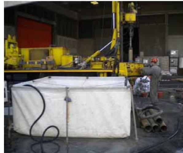
Vasca di stoccaggio acqua per approvvigionamento sondaggi con avanzamento a distruzione di nucleo
