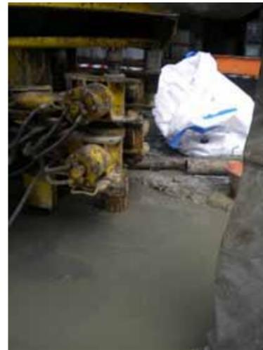
Dettaglio attività di perforazione a distruzione di nucleo
