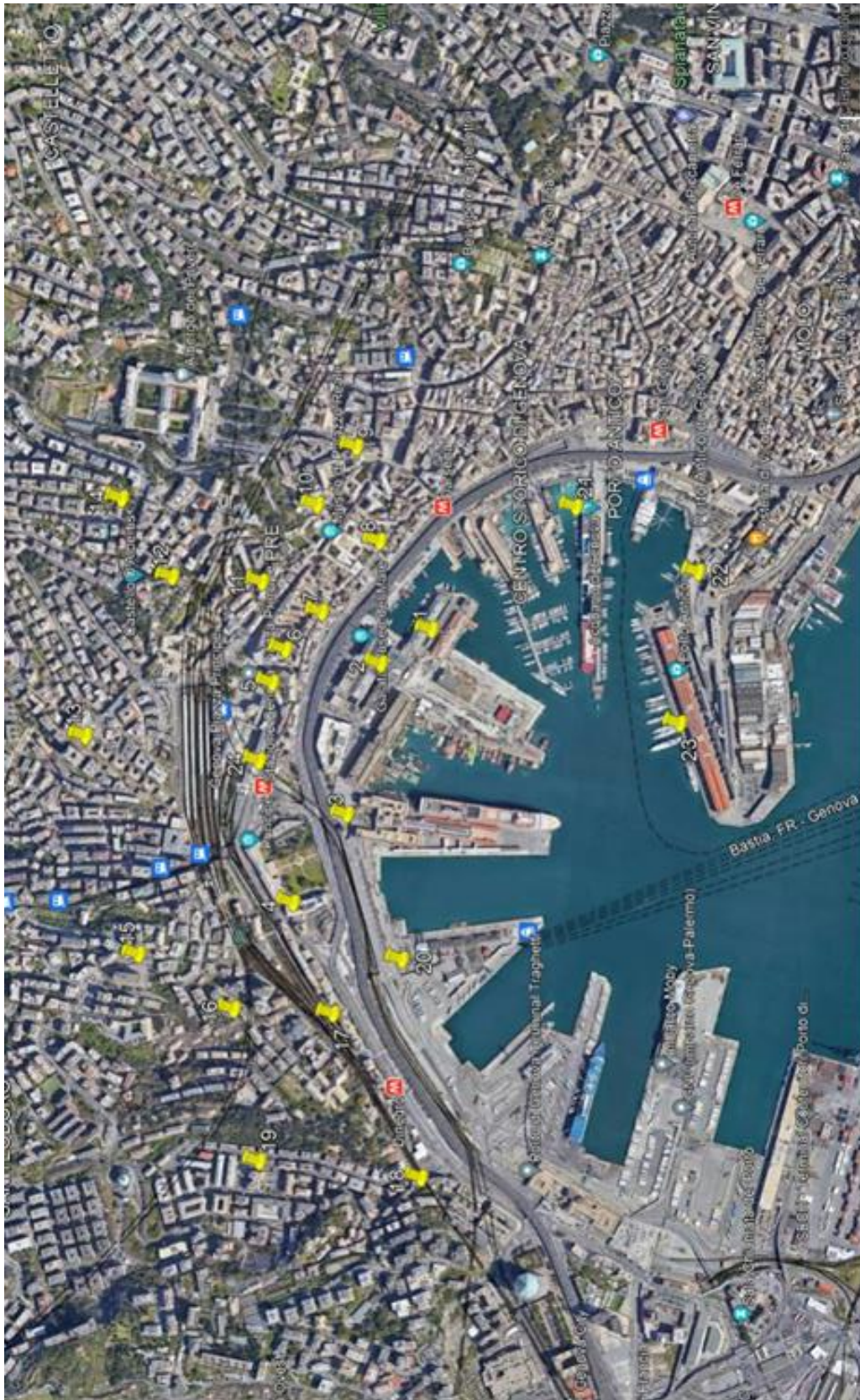
Figura 7-4 vista dall'alto – sono indicati i recettori discreti sui cui sono stati eseguiti i calcoli
