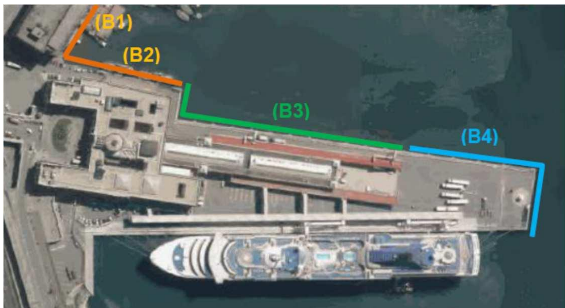
Figura 4-6 Caratterizzazione delle banchine esistenti
