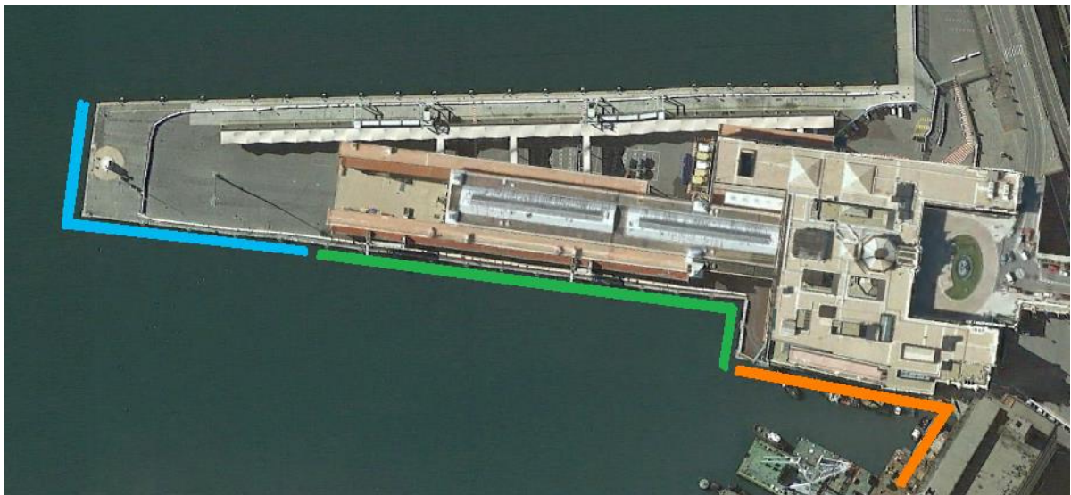
Figura 10: Stato attuale – Tipologie di strutture della banchina di Levante
