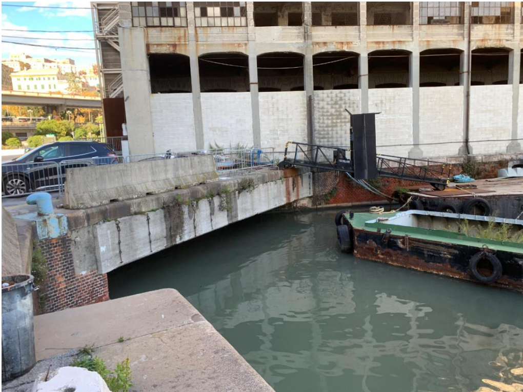
(2) Angolo Ponte dei Mille – Calata S. Limbania: foce Rio Lagaccio – Stato Attuale
