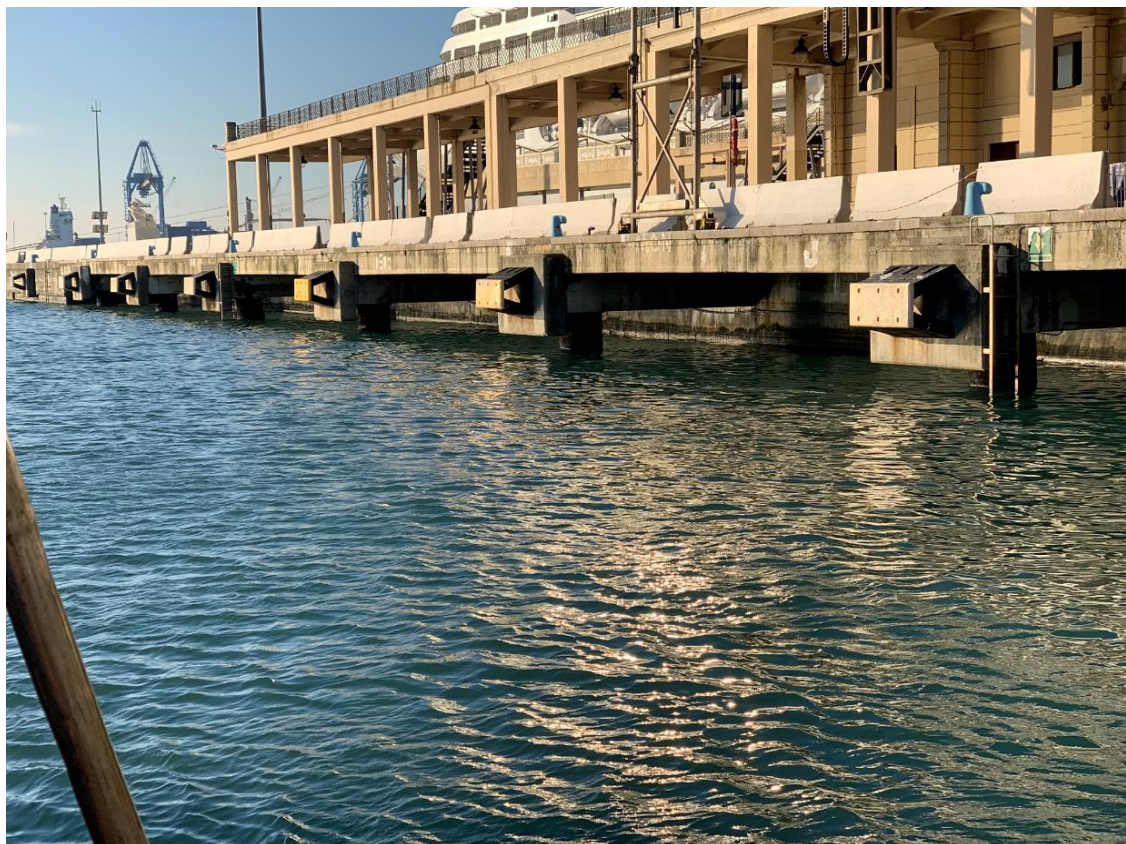
(3) e (4) Ponte dei Mille – Tratto banchina a giorno
