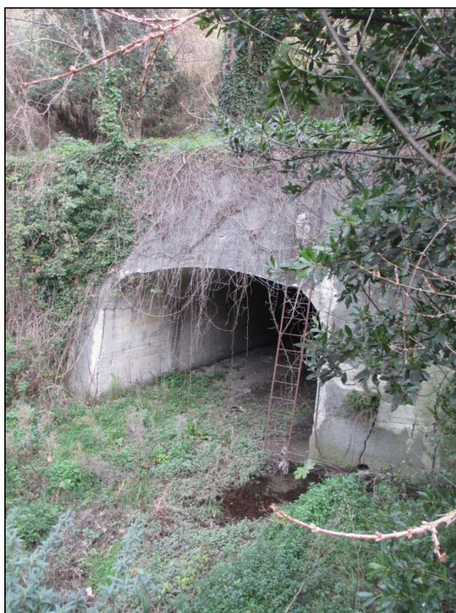
Foto 2: tratto a cielo aperto in corrispondenza Ponte don Acciai (vista tombino di monte)
