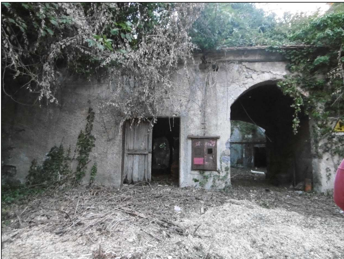
Foto 13: vista esterni in corrispondenza del tombino del Rio Cinque Santi (dopo la pulizia dell'area)
