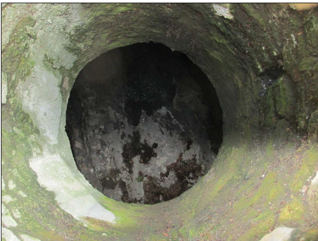
Foto 4: dettaglio deflusso tombinato visto dall'alto da chiusino (zona Caserma Gavoglio)
