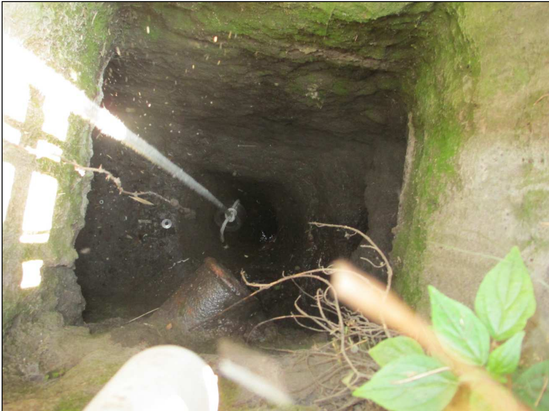
Foto 7: dettaglio dell'effluo tombinato visto dall'alto da chiusino con verifica speditiva quota fondo (zona Caserma Gavoglio)
