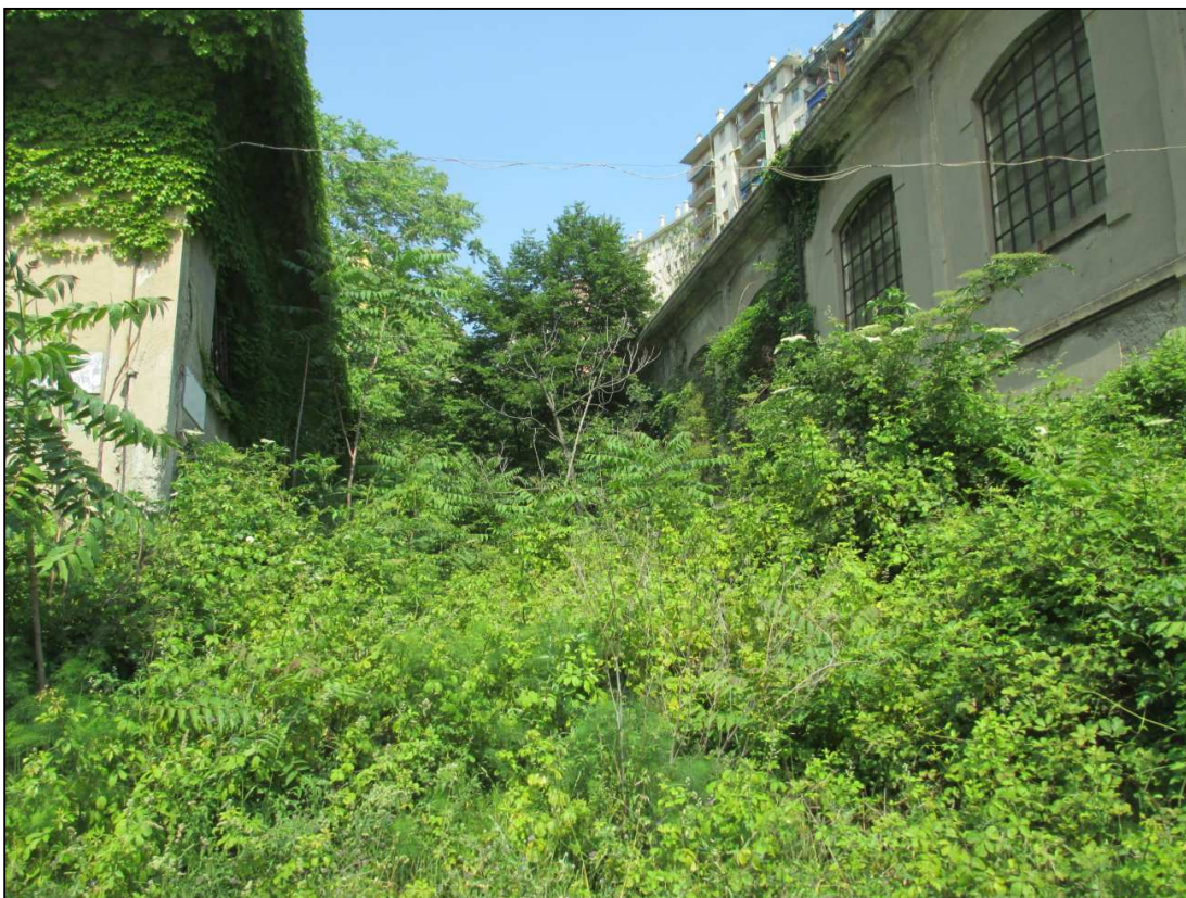
Foto 12: vista generale esterni capannoni Caserma Gavoglio in corrispondenza della confluenza Rio Lagaccio – Rio Cinque Santi (prima della pulizia dell'area)
