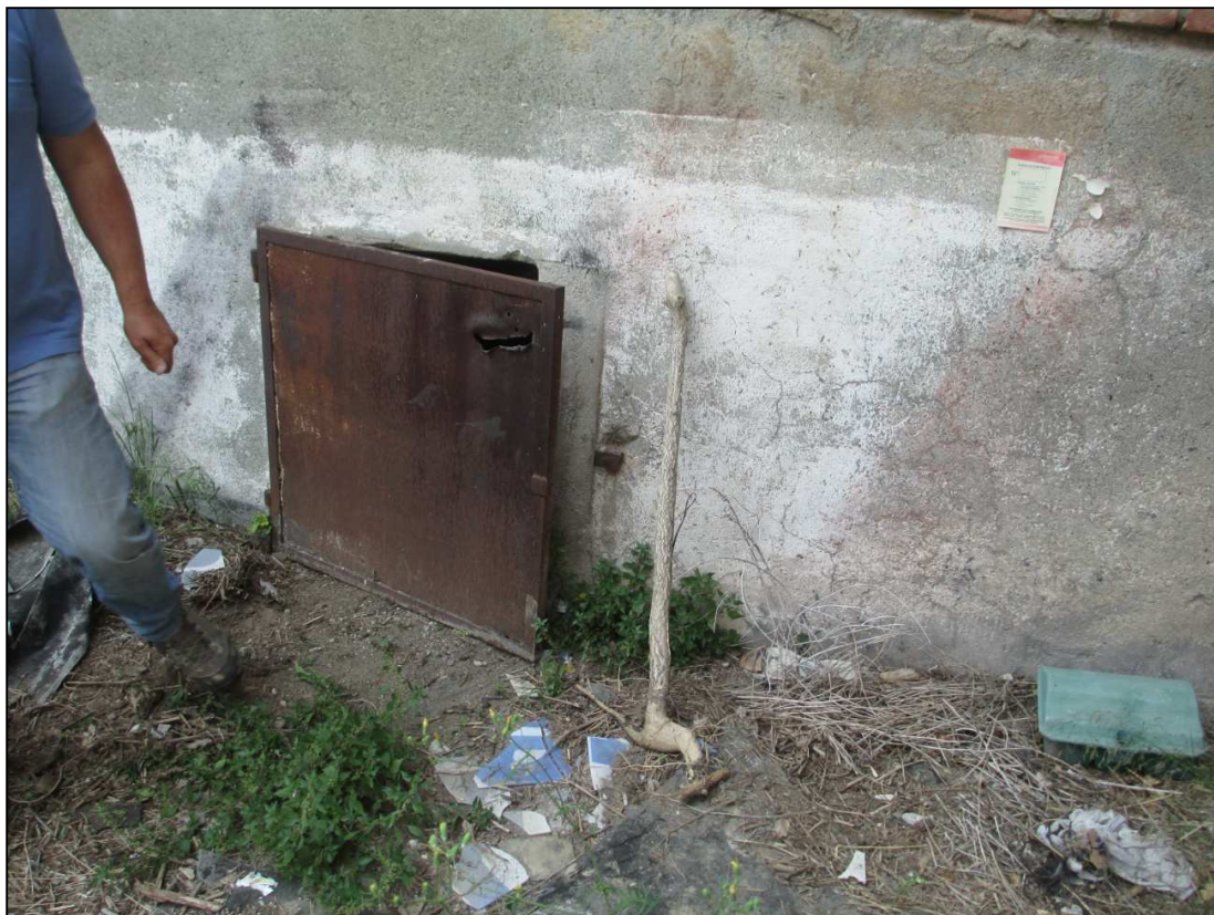
Foto 5: dettaglio apertura per accesso a tombino (zona Caserma Gavoglio)
