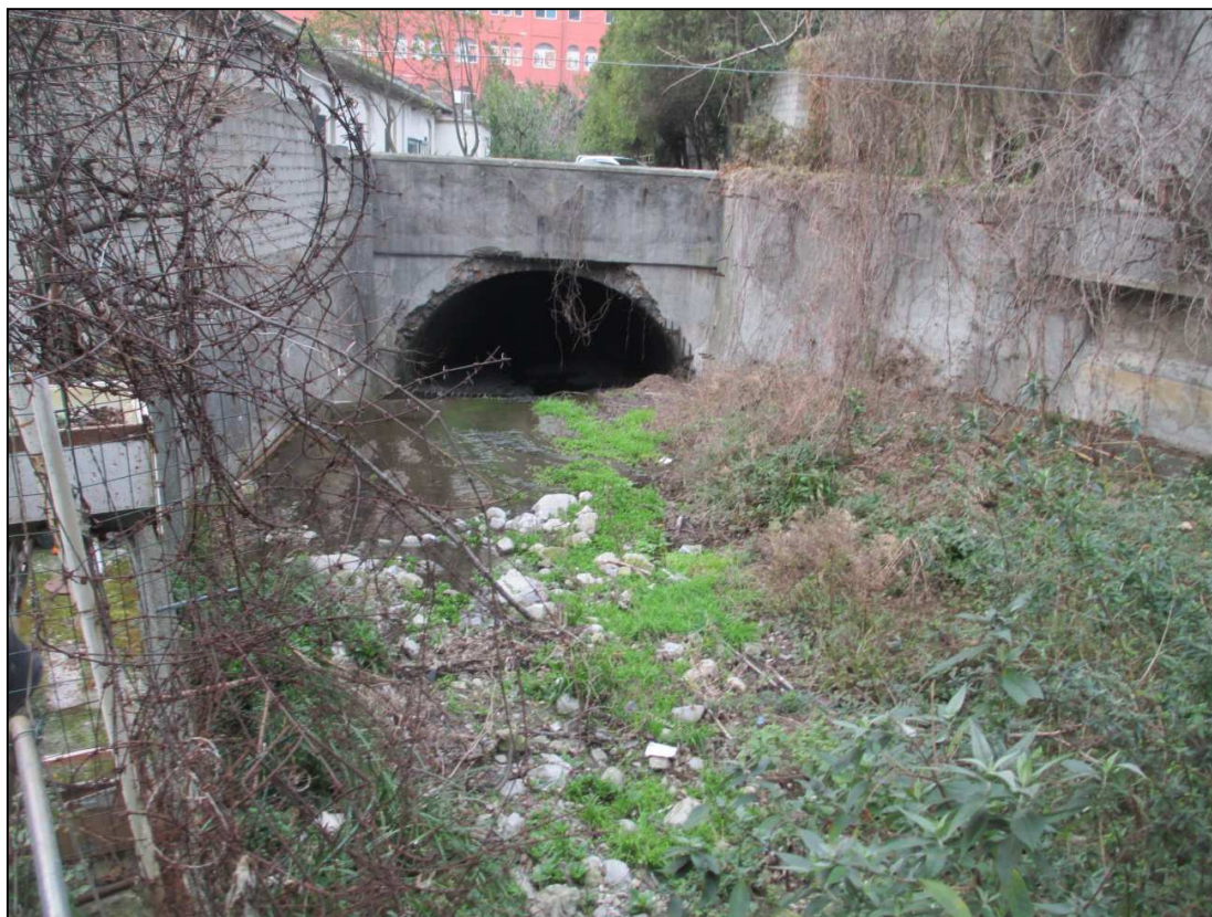
Foto 1: tratto a cielo aperto in corrispondenza Ponte don Acciai (vista tombino di valle)
