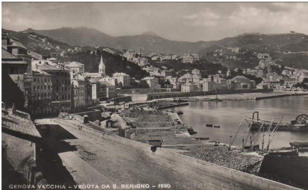
Figura 32. Calata S. Benigno. operazioni di interrimento e creazione delle nuove banchine.
