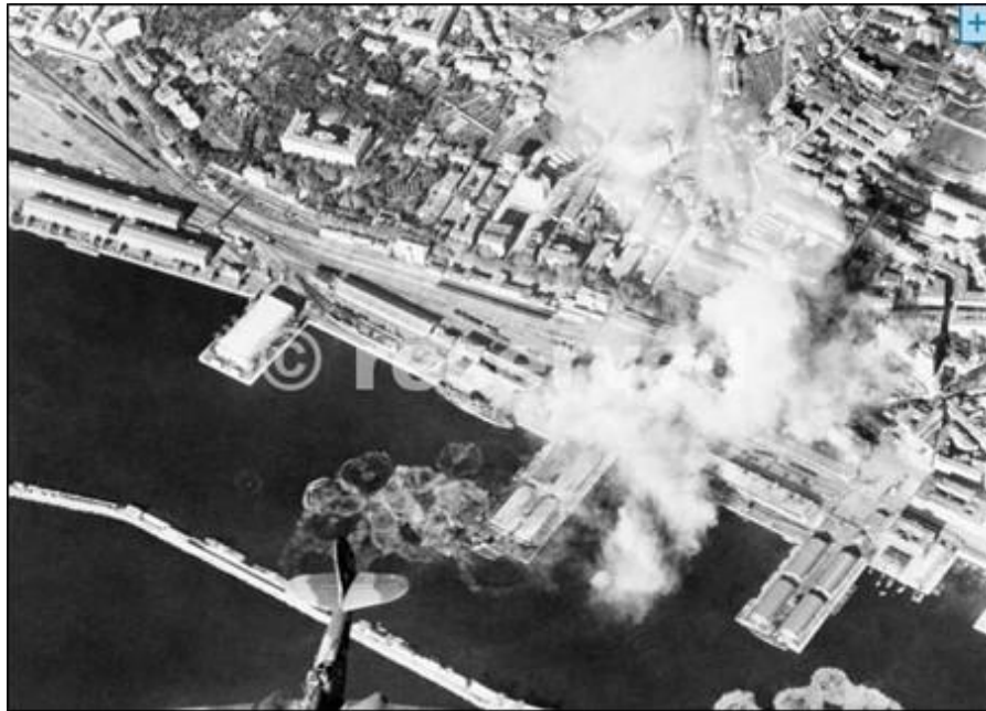
Figura 39 - Bombardamenti sull'area del porto del 1944
