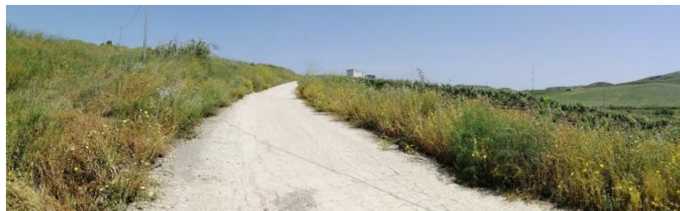
Figura 37 Strada Provinciale n° 64 – tratto di viabilità asfaltato.
