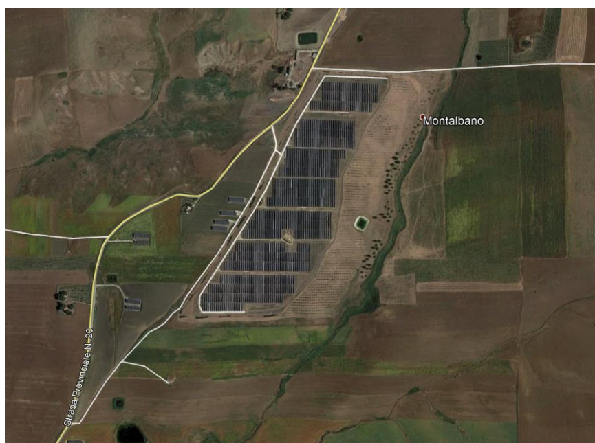
Figura 2: Impianto fotovoltaico Erg
