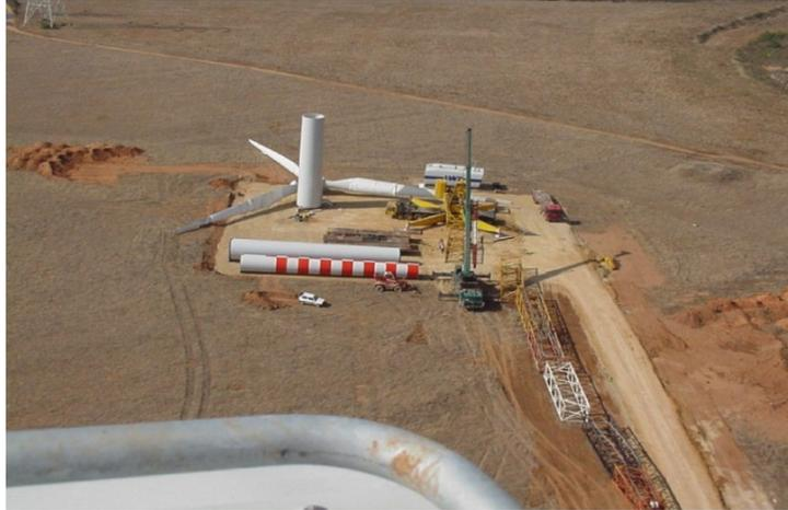
Figura 3 – Piazzola per il montaggio dell'aerogeneratore
