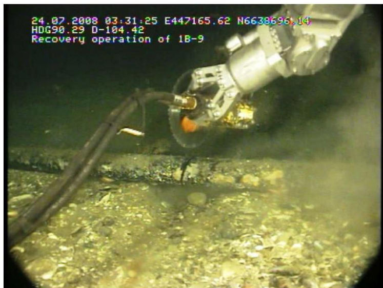
Figura 3.25 – Taglio spool con smerigliatrice
