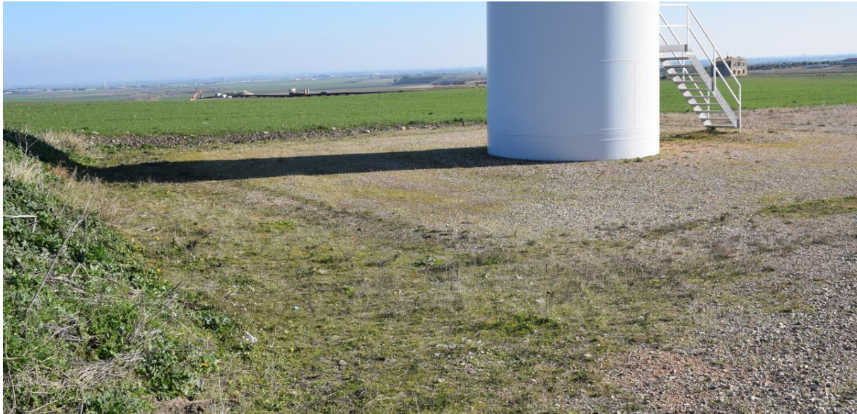
Impianto Eolico di proprietà nel Comune di Lucera (FG) – Impianto in esercizio – si noti la pressoché totale restituzione delle aree all’agricoltura con i ripristini delle piazzole e delle strade
