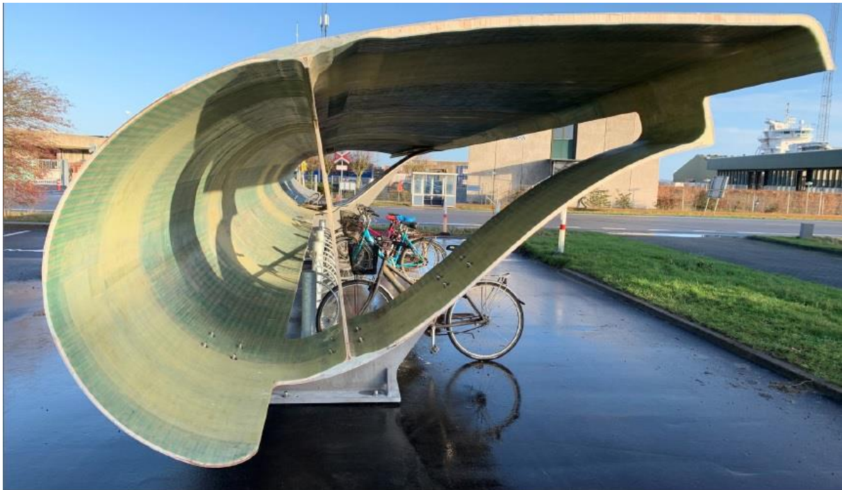
Figura 4 – Esempio di riutilizzo della pala come pensilina per biciclette ad Alborg, Danimarca (fonte: Accelerating wind turbine blade circularity )
