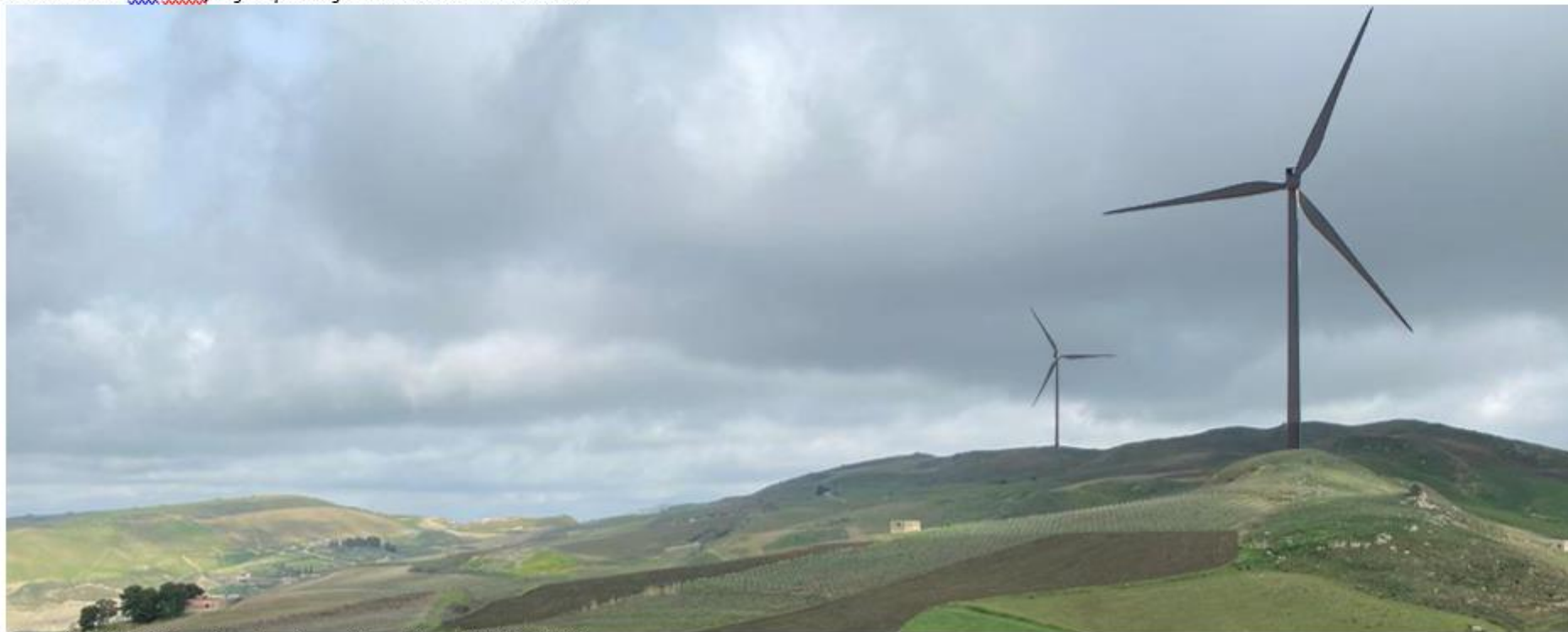
Panoramica dalla C.da Prajno, lungo la quale sorge il Parco Eolico - FOTOMONTAGGIO
