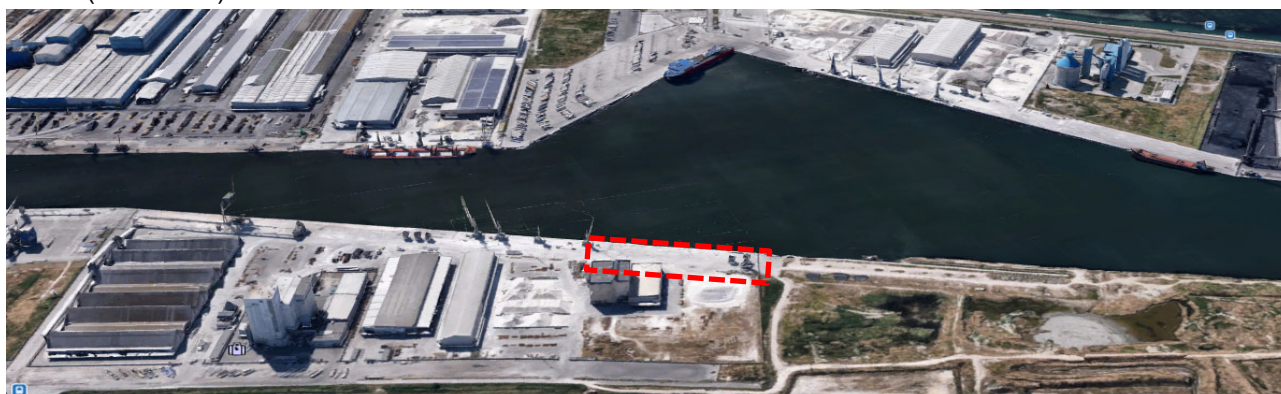
Figura 19 – Inquadramento banchina Docks Piomboni Nord
