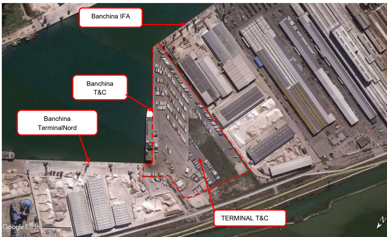
Figura 16 Banchina Trattaroli Sud – Terminal traghetti T&C
