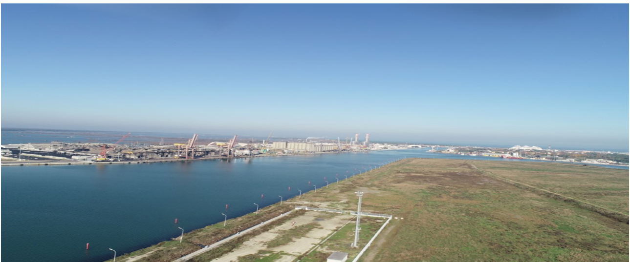
Figura 28: Foto Banchina Nuovo terminal container
