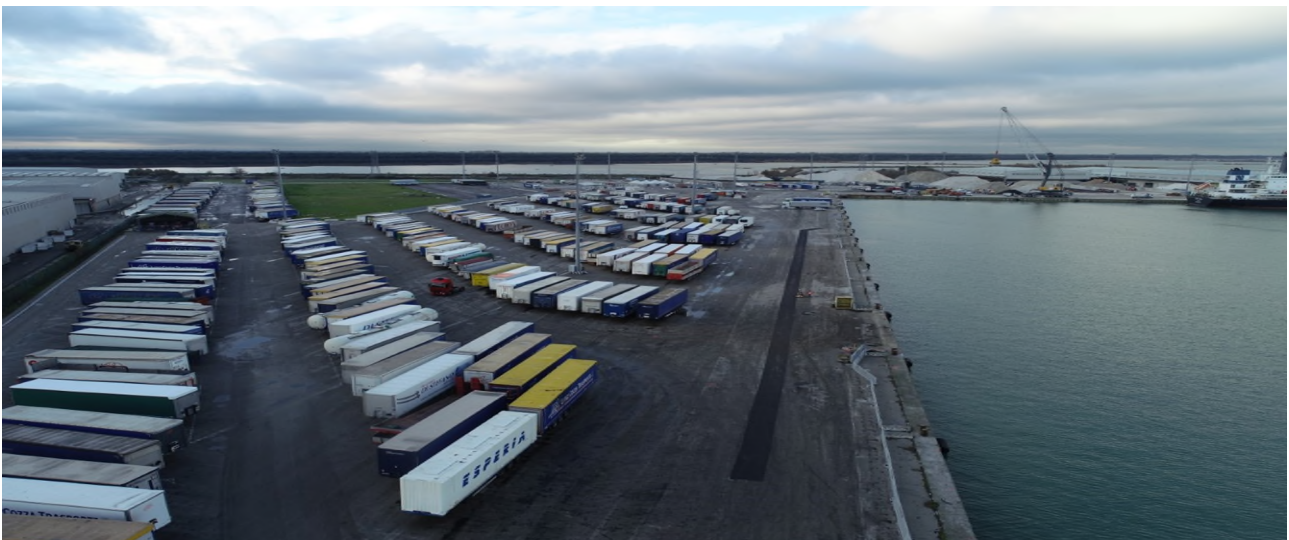
Figura 18: Foto Banchina Trattaroli Sud T&C
