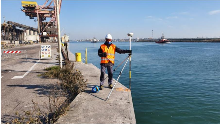
**Figura 2: rilevamento di un flesso nell'andamento planimetrico della trave di banchina**
