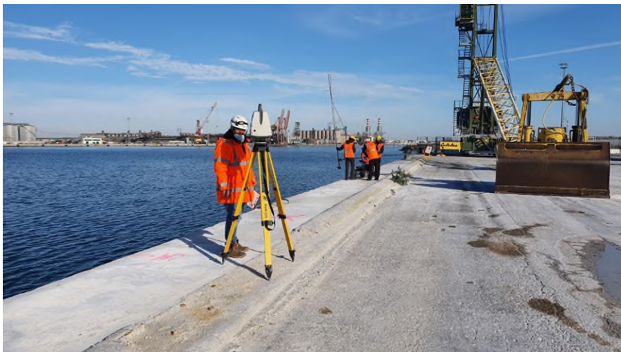
Figura 6: il Laser Scanner Terrestre in stazione su una banchina
