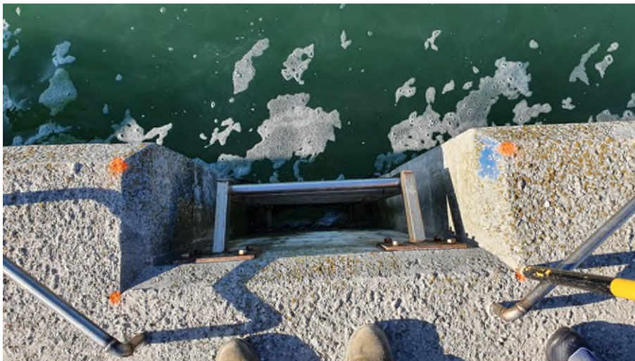
Figura 3: esempio di nicchia di una scaletta e dei punti battuti per il rilievo topografico
