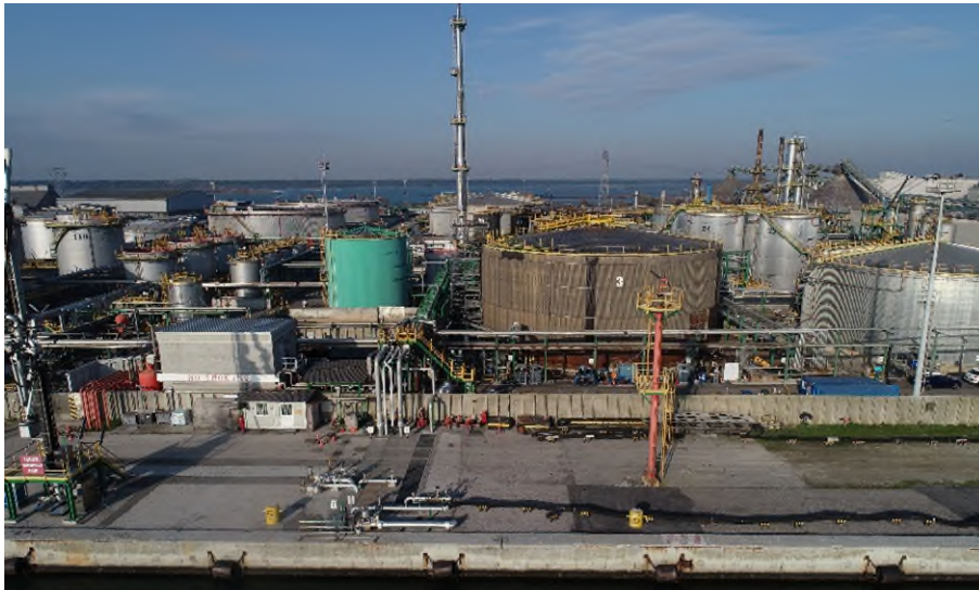
Figura 13: Esempio di foto obliqua di banchina non sorvolabile, per la presenza di impianti a rischio incendio/esplosione.
