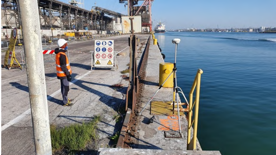
Figura 42: HUB_ba18, uno dei caposaldi materializzati e battuti sulla banchina
