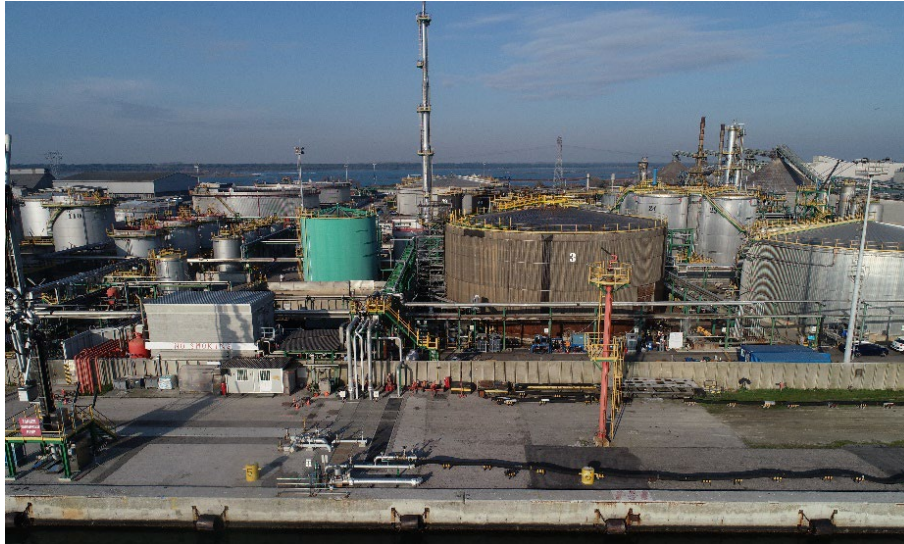
Figura 13: Esempio di foto obliqua di banchina non sorvolabile, per la presenza di impianti a rischio incendio/esplosione.
