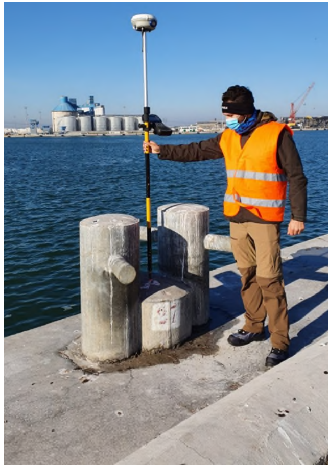
Figura 4: tecnica di misura delle bitte – asse testa
