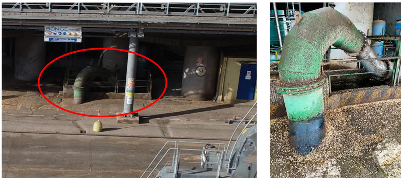
Figura 16 - Vasca di raccolta e tubazione di scarico in acciaio
