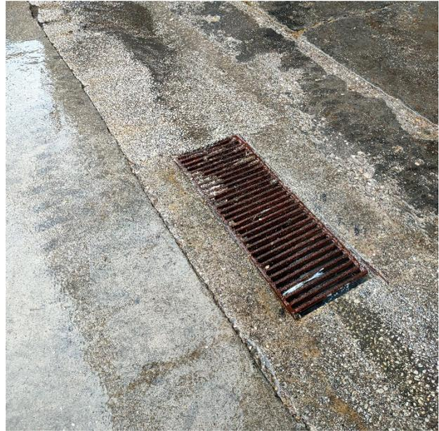
*Figura 1-2 – Griglia per raccolta delle acque meteoriche della rete attuale*
