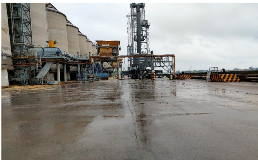
Figura 1-5 – Superficie di banchina allo stato attuale. Si nota la pendenza costante dalla trave ai silos e l'assenza di caditoie e pozzetti sulla pavimentazione
