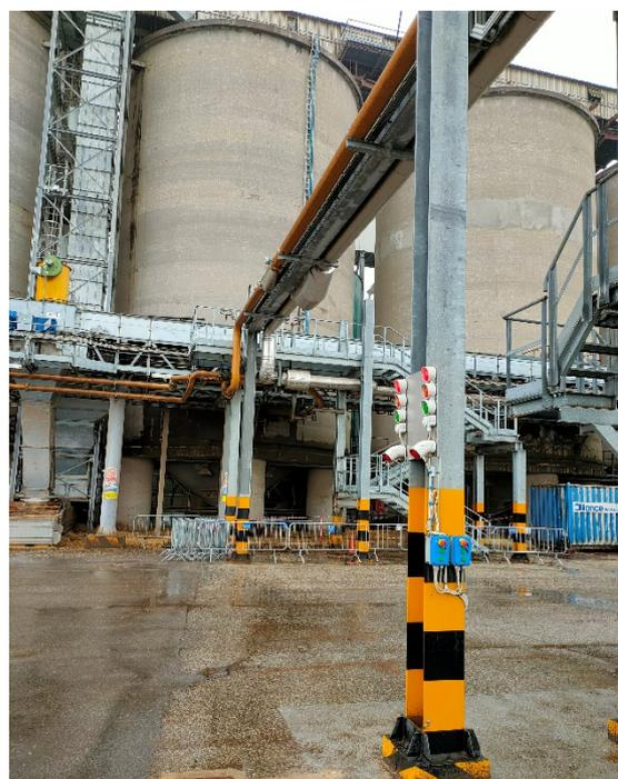
Figura 1-7 – Attraversamento di banchina delle tubazioni e allacciamento al piperack
