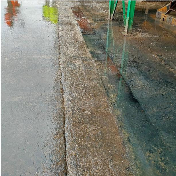
*Figura 1-1 – Canaletta attuale per smaltimento acque meteoriche nella zona sotto ai silos*
