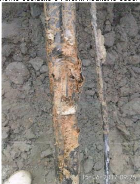
Figura 16 – Fotografia del tirante di ancoraggio a tergo della trave
