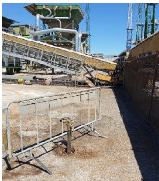
Figura 23 - Manicotto impianto antincendio esistente
