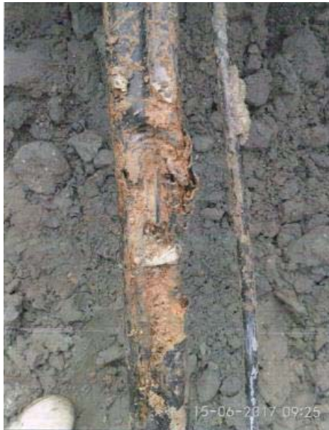
Figura 15 – Fotografia del tirante di ancoraggio a tergo della trave
