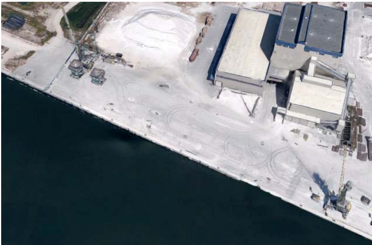
Figura 6 – Vista aerea 3D recente della banchina Docks Piomboni Nord (da Google maps, 2017)
