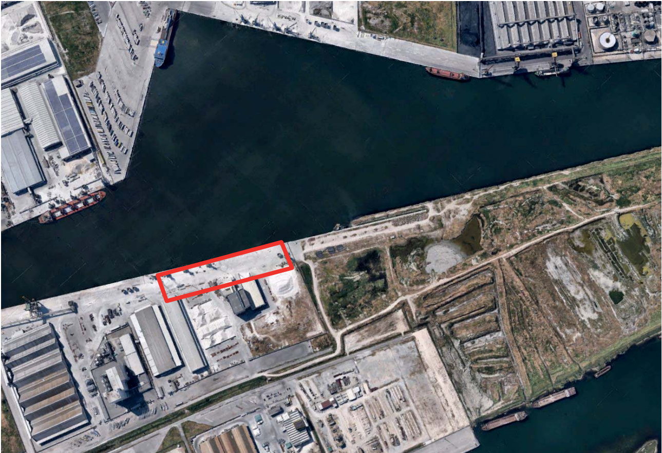
Figura 1 – Inquadramento banchina Docks Piomboni Nord
