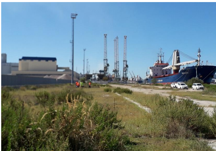
Figura 11 – Torri faro esistenti in banchina N1.
