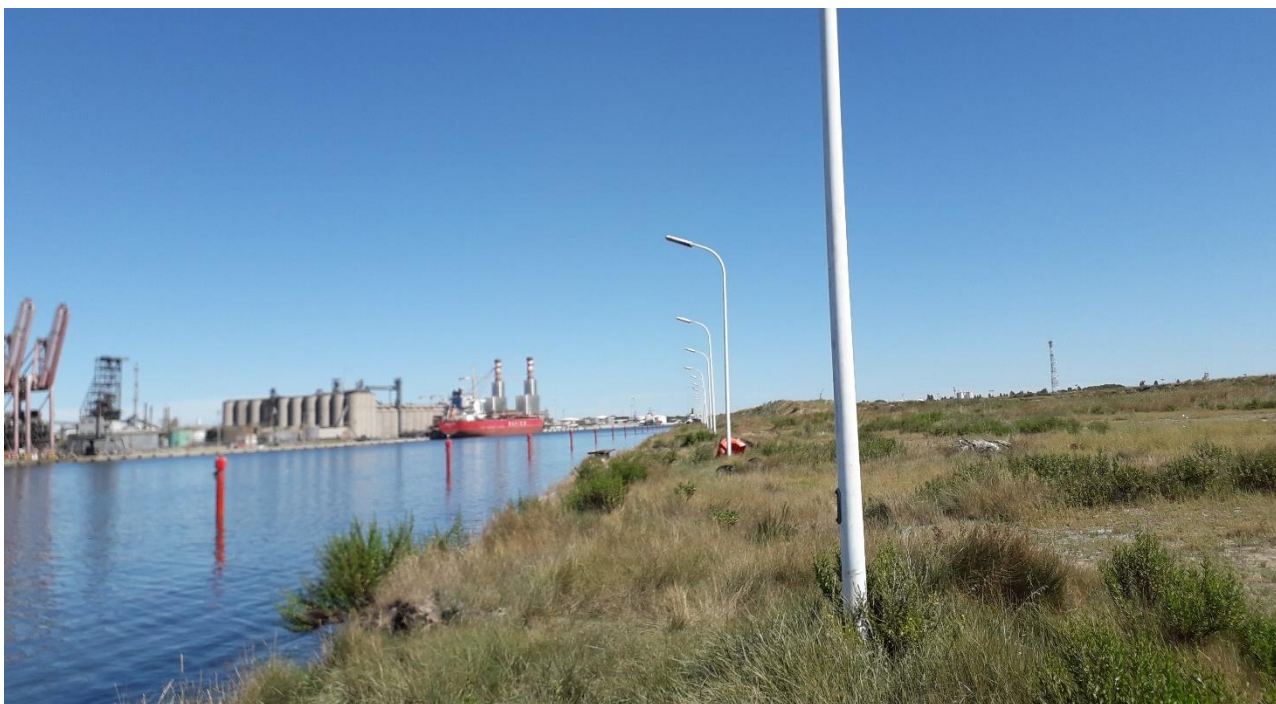
Figura 8 – Servizi - sottoservizi e pali segnalatori presenti nel rilevato
