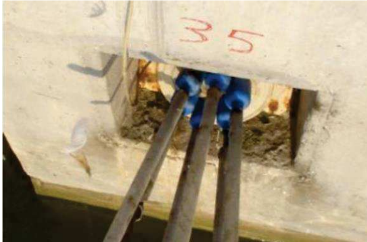
Figura 21 - Testata di ancoraggio della banchina Trattaroli Destra pronta per il taglio dei trefoli e per la sigillatura della nicchia. Si notano le capsule protettive installate sui dispositivi di serraggio dei trefoli.
