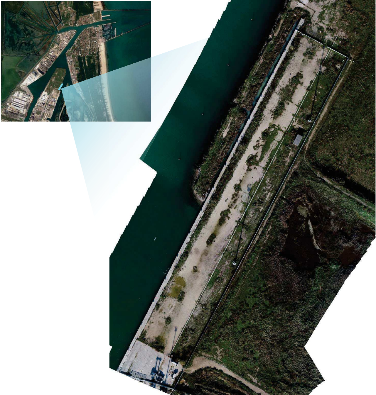
Figura 2 – Ortofoto mediante drone Nuovo Terminal Container – Sopraelevazione (Banchina N1)
