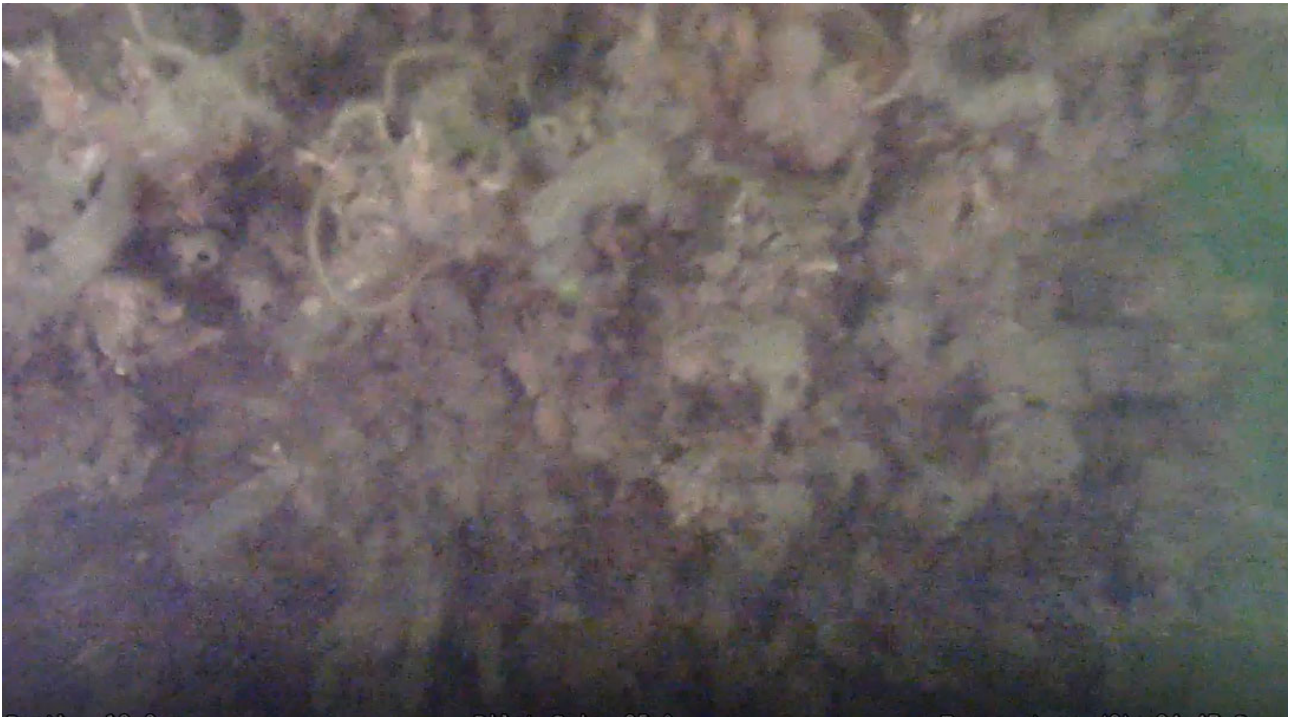
Figura 16: particolare del blocco di CLS con concrezioni (al minuto 3:38)
