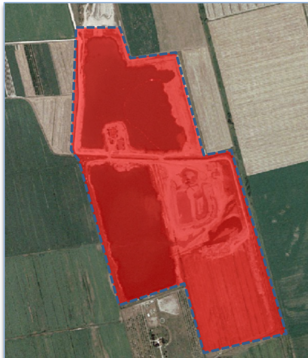
Figura 38 – Foto aerea del 2000 della zona occupata dalla cava La Bosca (fonte: sito internet del comune di Ravenna)
