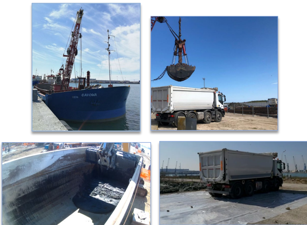
Figura 9 – Test in scala reale di scarico e gestione dei materiali di dragaggio con “GHD – Grab Hopper Dredger” nelle vasche di accumulo intermedie previste in fase esecutiva
