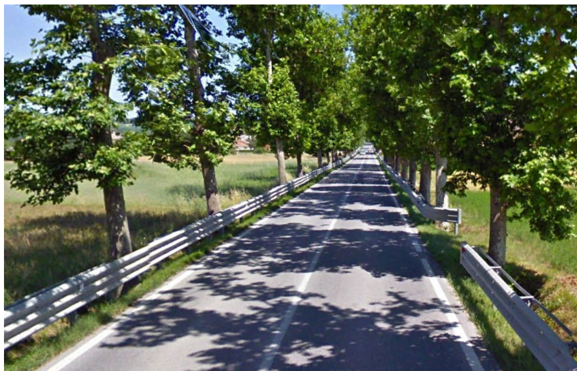
SS073 bis – Dir Fano - Inizio intervento
