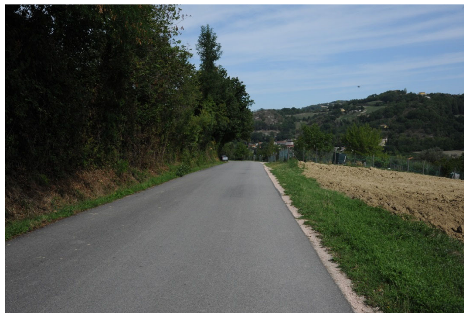
P.11 – Foto 2 – Vista verso nord della viabilità esistente che verrà modificata dal progetto
