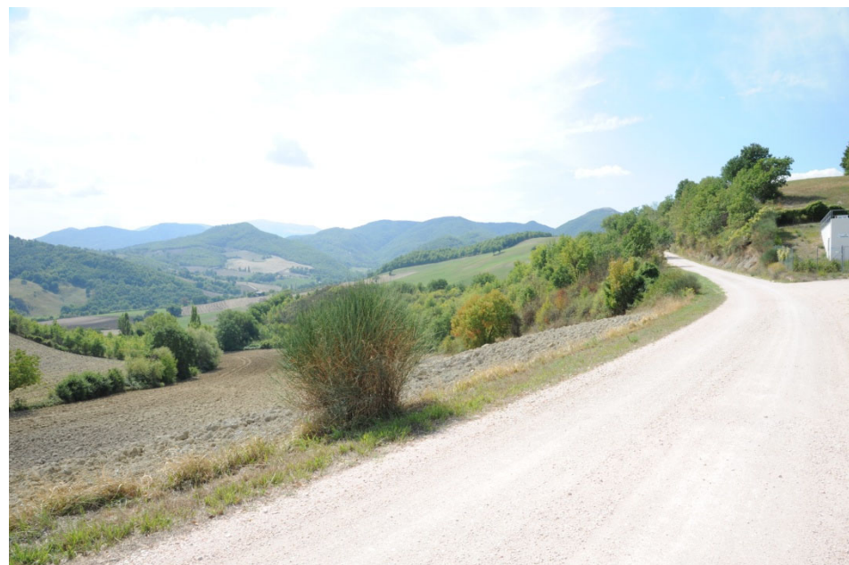
P.6 – Foto 3 – Vista verso ovest dell'area al di sopra della galleria Urbania 2
