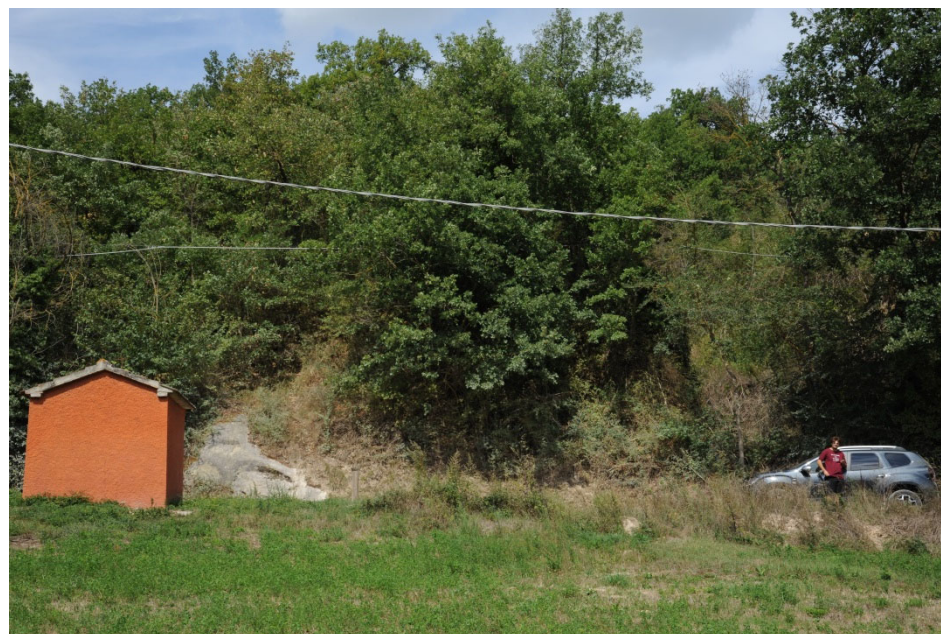
P.5 – Foto 1 – Vista verso nord-ovest al di sopra del tracciato di progetto (galleria Urbania 2)
