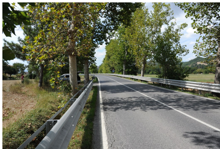
P.1 – Foto 1 –Vista verso ovest della viabilità esistente dalla rotatoria in progetto (SS n° 73 bis).
