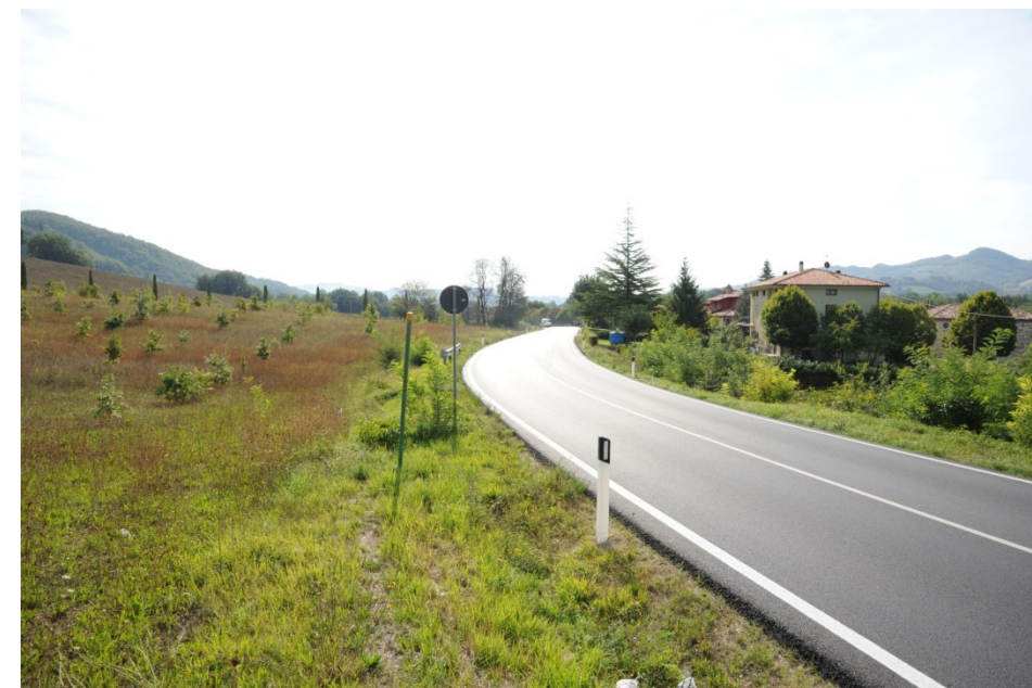
P.15 – Foto 1 – Vista verso est della viabilità esistente che verrà raccordata tramite rotatoria di progetto (S.P. Metaurense n°4)
