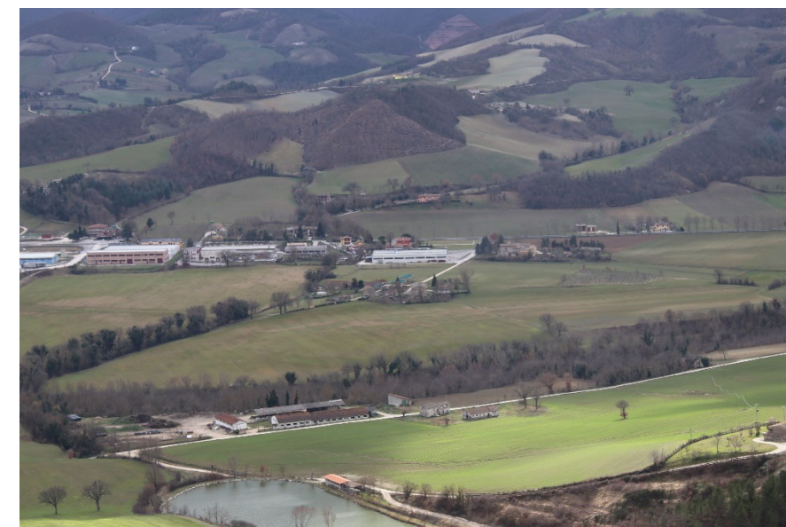
P.16 – Foto 2 – Vista verso sud-est. Dal nucleo storico sarà visibile il tratto iniziale sino all'imbocco della galleria "Il Monte"
