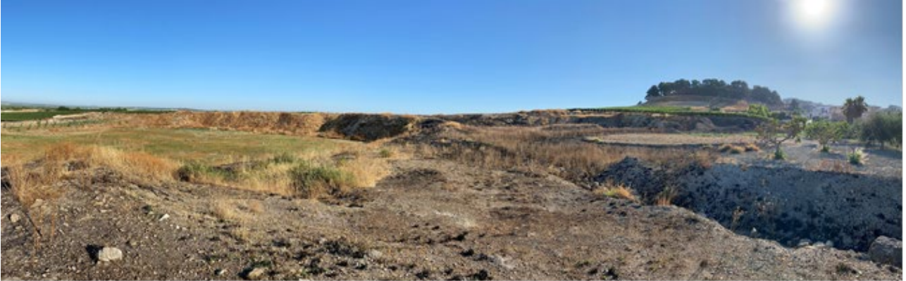
FOTO 2 – Area tra le pk 24 +200 ÷ 24+400. Veduta frontale dell'affioramento: si possono osservare varie altezze (livelli) del piano campagna dovuti ad attività di scavo. L'area dista circa 90 metri dalla linea ferroviaria.
