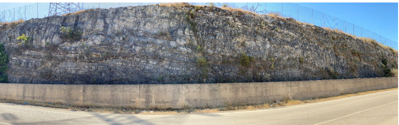
FOTO 3 - Area tra le pk 24+600 ÷ 25+200. Strada parallela alla stazione di Canosa di Puglia. Taglio stradale nelle Calcareniti di Gravina. L'altezza varia dai 2 ai 3.5 metri circa. E' presente un muretto in calcestruzzo armato al piede dell'affioramento per il contenimento di detriti di dilavamento e per convogliare le acque piovane. La parete dista circa 15 metri dalla linea ferroviaria
