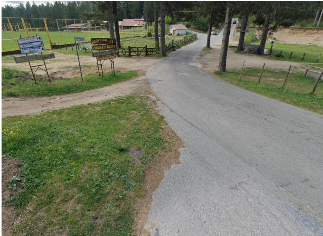
Foto n.1 ante operam: accesso all' Aviosuperficie Franca
