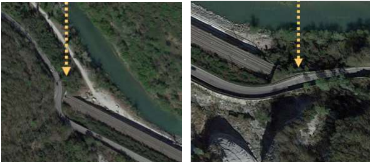
Figura 2: Dettaglio del nodo 1 (a sinistra, al km 47+530) e del nodo 2 (a destra, al km 47+850) (Fonte: Lista di controllo)
