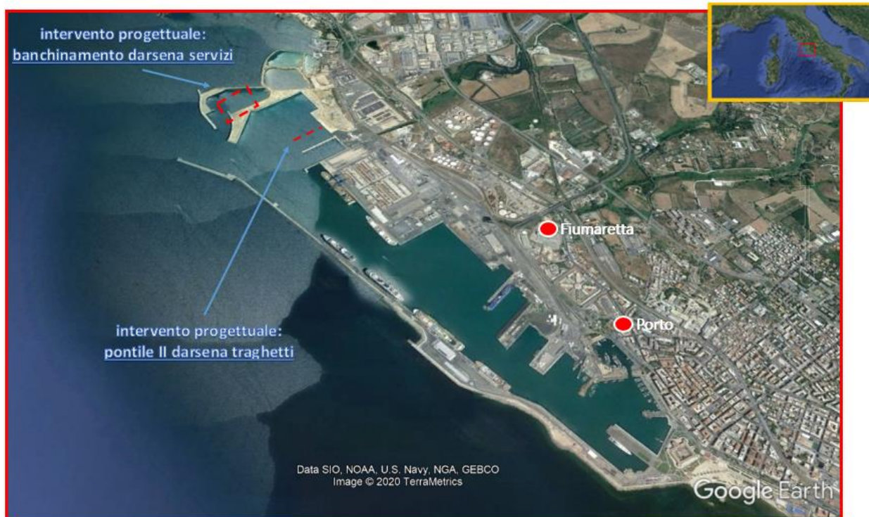
Figura 3: Porto di Civitavecchia, aree di intervento progettuale riguardanti le opere strategiche denominate “Pontile II darsena servizi” e “Banchinamento darsena servizi” e centraline di monitoraggio per la qualità dell’aria.
