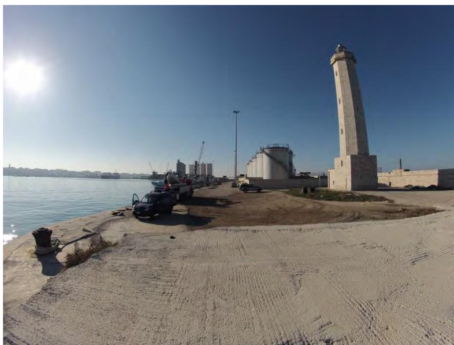
Figura 31. Cantiere a terra in testata al molo di Tramontana
