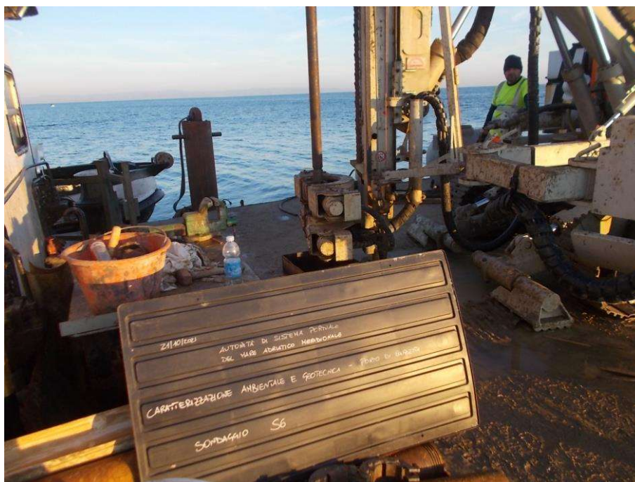
Foto 31: Sondaggio BT01-006 - Postazione
