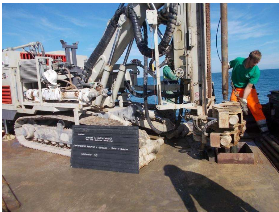
Foto 25: Sondaggio BT01-005 - Postazione
