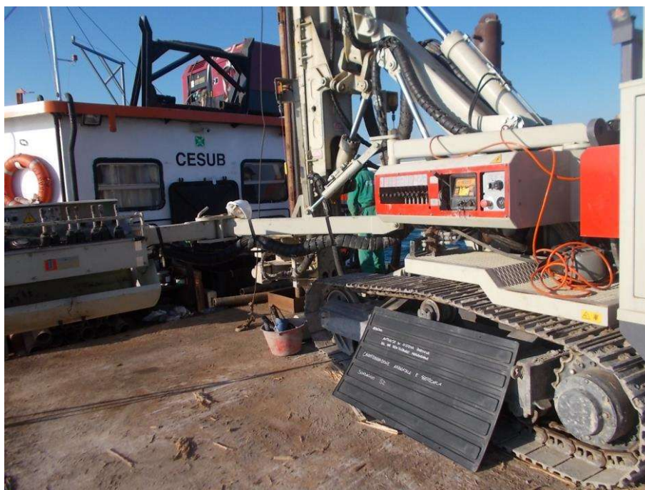
Foto 7: Sondaggio BT01-002 - Postazione
