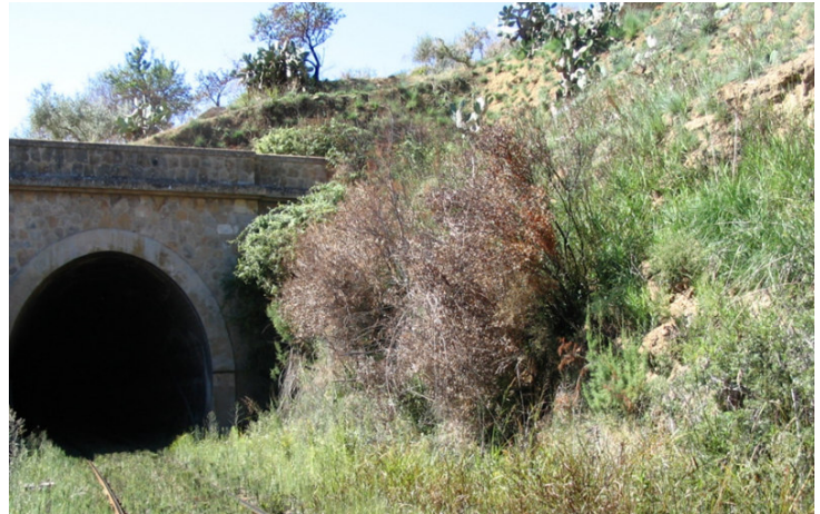
Figura 15: Situazioni tipologiche degli imbocchi: muri d’ala non sempre presenti
