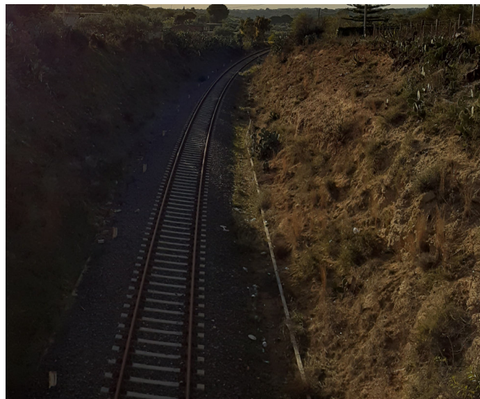
Figura 2.4 Trincea ferroviaria presente sulla tratta in oggetto (altezza H ÷ 4-7m)
