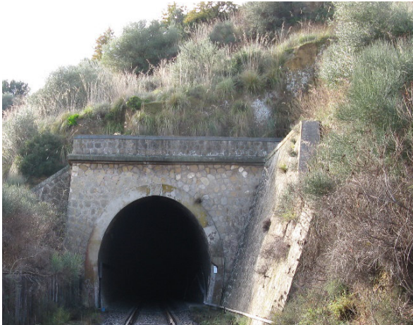
Figura 15: Situazioni tipologiche degli imbocchi: muri d’ala non sempre presenti
