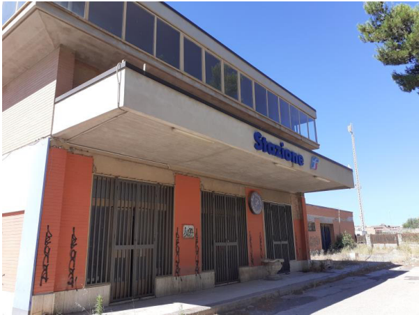
Figura 6 – Fabbricato viaggiatori prospetto principale lato piazzale.
