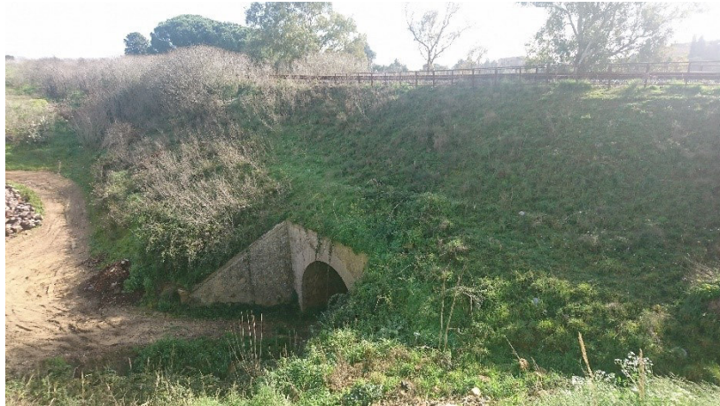
Figura 2.2 Rilevato presente sulla tratta in oggetto prog. 318+042
