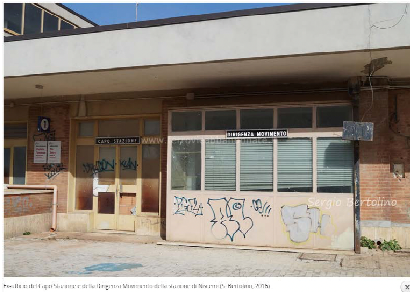
Figura 5.2 - Dirigenza Movimento della stazione di Niscemi (fonte: https://www.ferrovieabbandonate.it/linea_dismissa.php?id=252 ).
