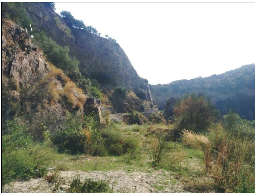
Figura 11 – Gole del Neto – Scarpata orientale in asse tracciato aereo.
