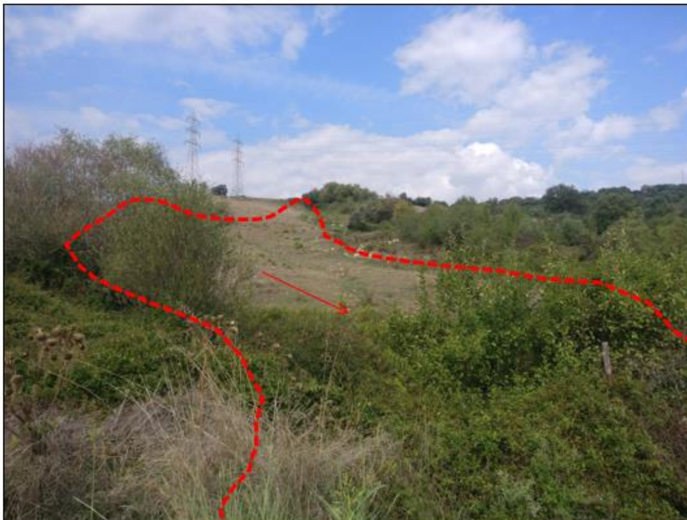
Figura 2 – Vista dal basso di un dissesto franoso (delimitato in rosso) che interessa il versante sinistro del Fiume Neto, nel settore esterno alle Gole, poco a monte della SP31.
