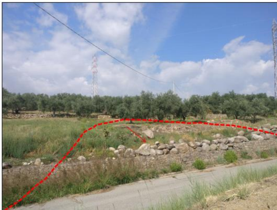
Figura 3 – Struttura di contenimento realizzata in gabbioni e massi ciclopici in testa, sistemata a protezione della SP32 presso il sostegno 8 della nuova linea di progetto.
