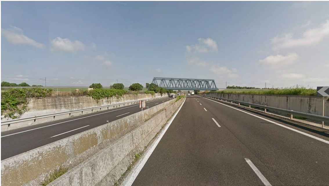
Figura 4-14 Punto di vista 02. Condizioni percettive post operam.
