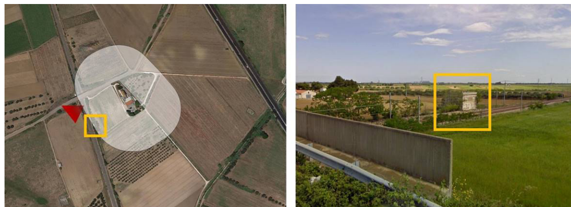
Figura 4-7 Fabbricato in demolizione.
