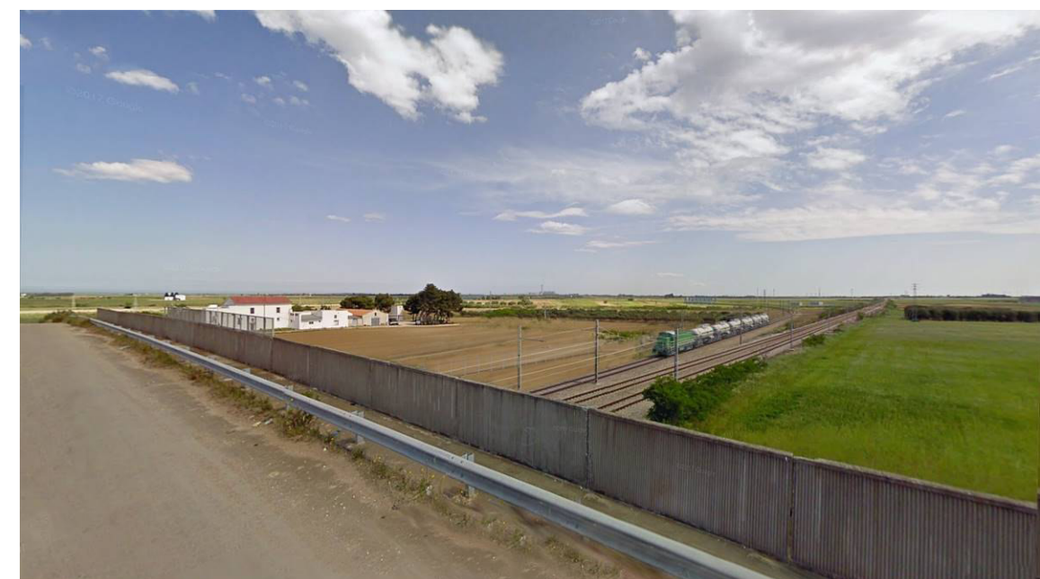
Figura 4-13 Punto di vista 01. Condizioni percettive post operam.
