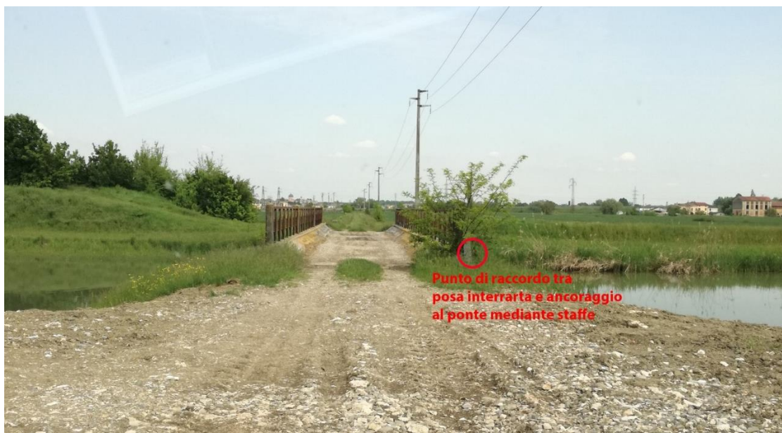
Figura -1 – Ponte sul cavo parmigiana con punto di raccordo tra elettrodotto interrato e ancoraggio al ponte.
