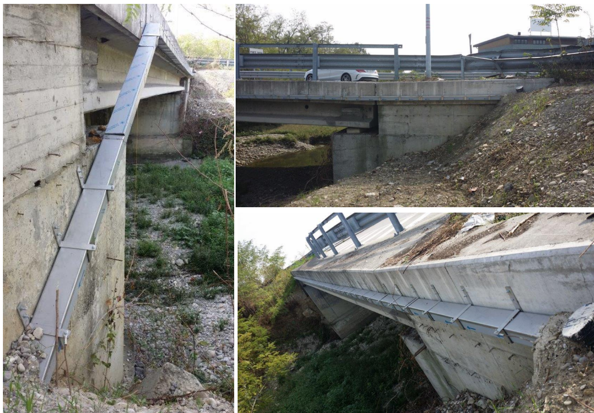
Figura -2 – Esempi di attraversamento in canalina su ponte esistente in aree tutelate
