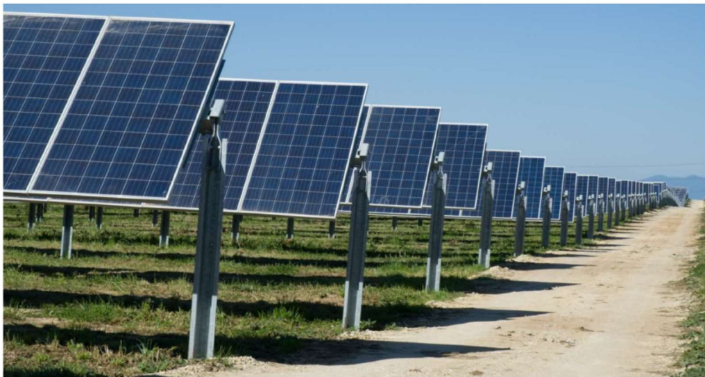
Figura 2.7 Stato del cantiere al termine dei lavori
