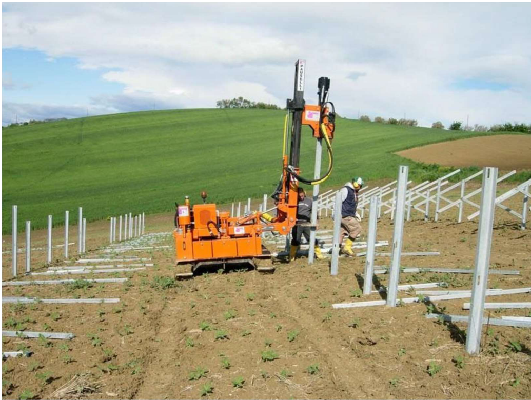
Figura 2.6 Posa strutture metalliche di fondazione
