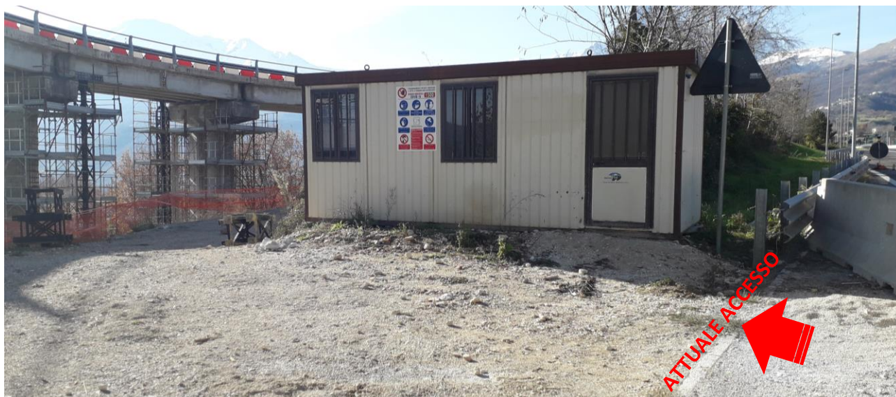
Figura 25 - Stato attuale della zona destinata ad area Cantiere Sud
