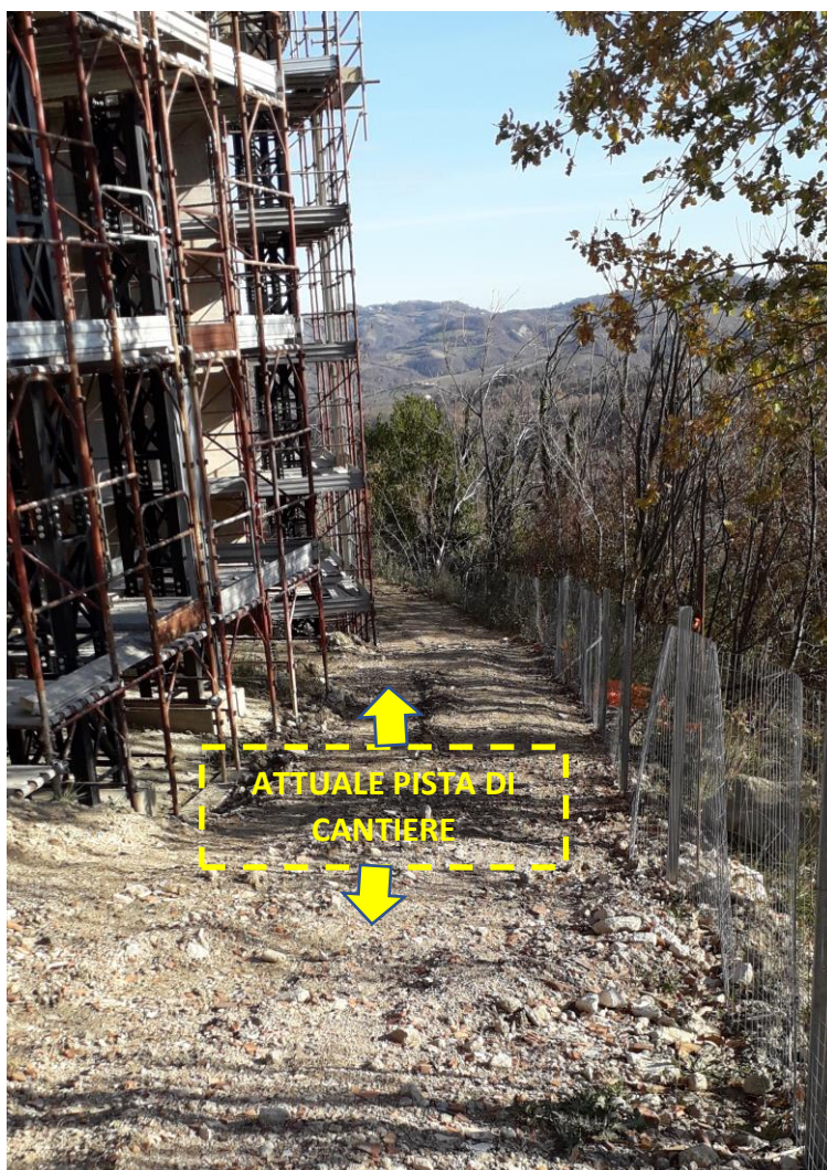
Figura 26 - Pista di cantiere attualmente già presente sul perimetro esterno del viadotto esistente
