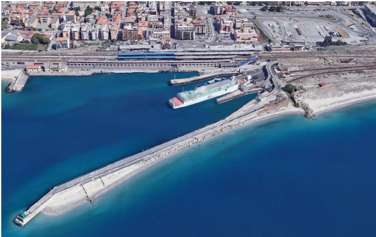
Figura 3: La Stazione ferroviaria di Villa San Giovanni e l'area delle invasature
