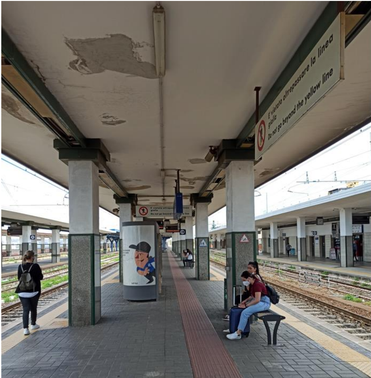
Figura 21 - Marciapiede 2 coperto da pensilina storica in C.A.
