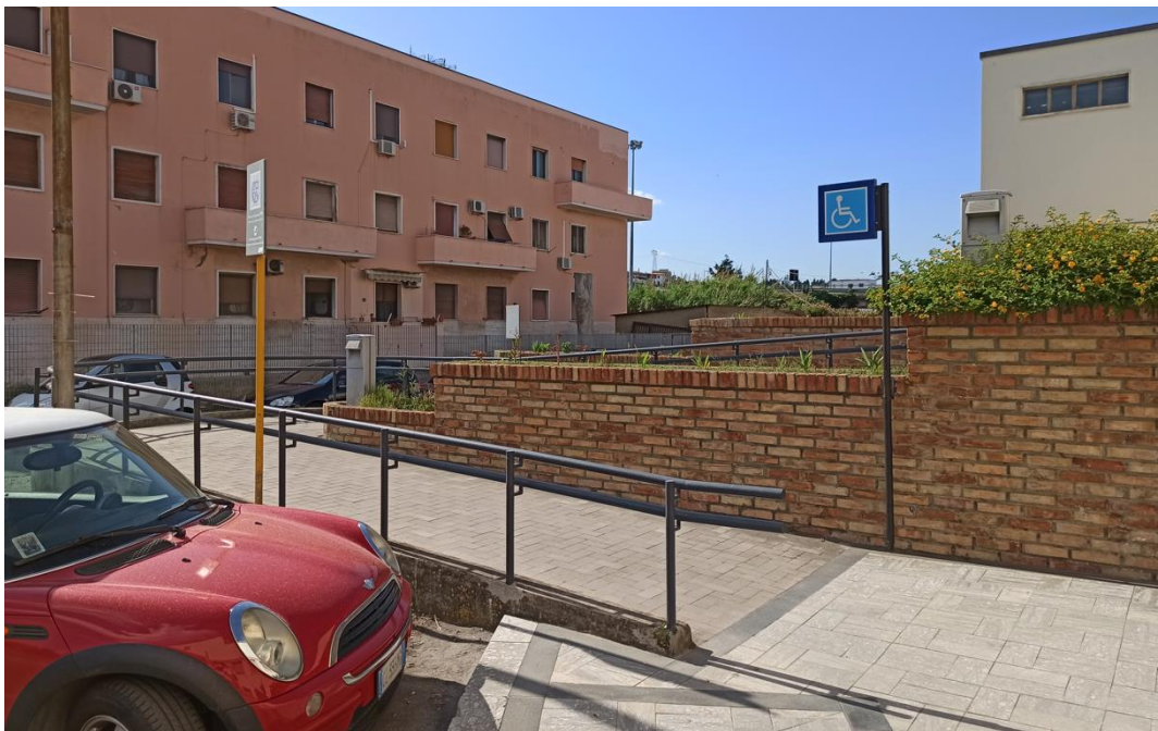
Figura 16 - Rampa di accesso PRM
