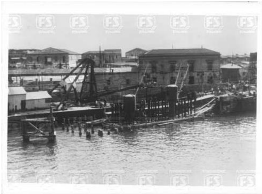
Figura 11 - Invasature in fase di realizzazione (1934 circa)
