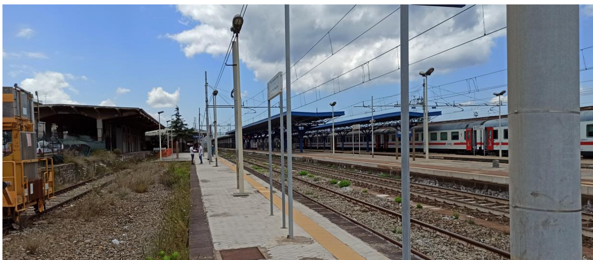
Figura 20 - Restringimento del marciapiede 1
