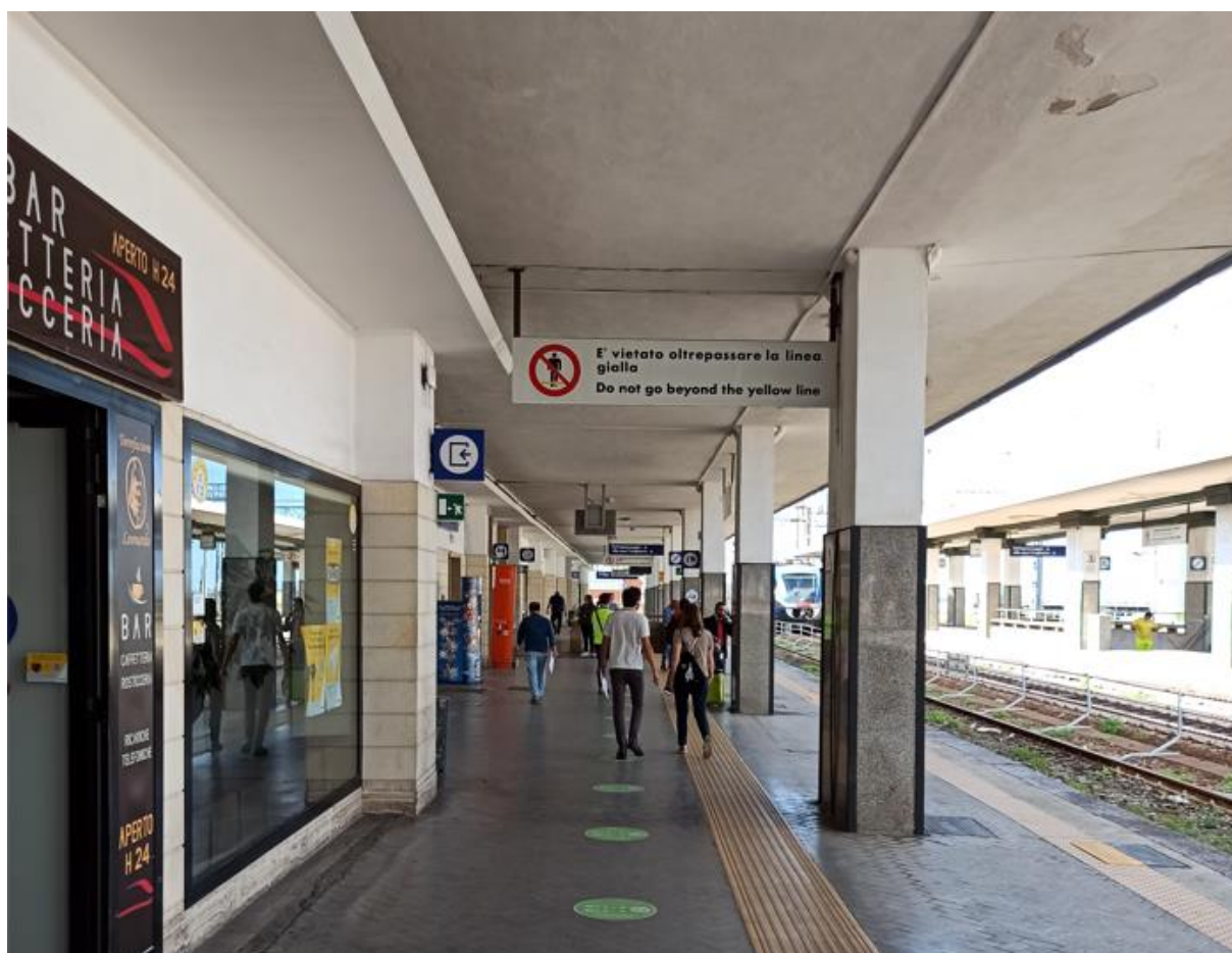
Figura 19 - Primo marciapiede coperto da pensilina
