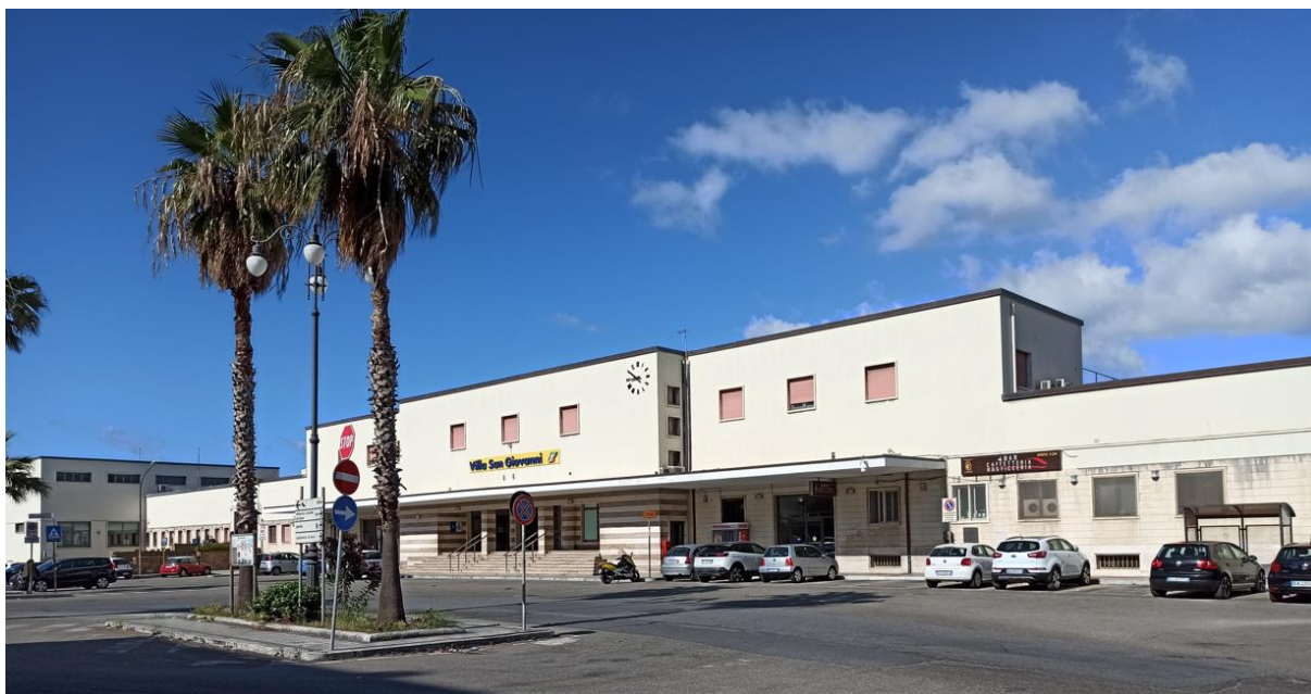
Figura 13 - Il piazzale di Stazione con il Fabbricato Viaggiatori
