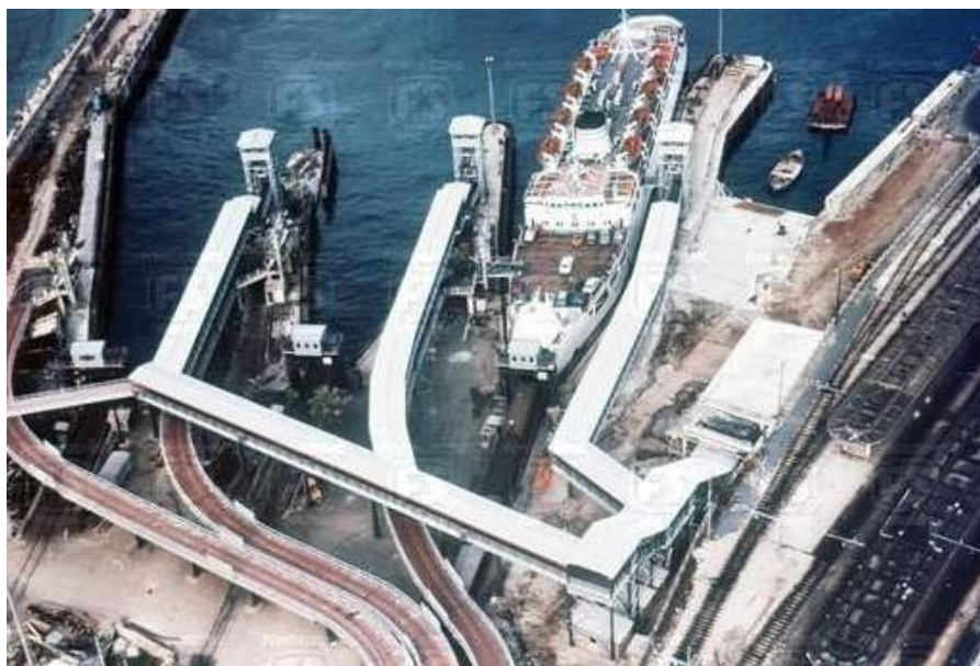
Figura 12 - Fotografia del 1974 dell'invasatura 1 con nave traghetto ormeggiata. Sulla destra si vede il piazzale oggetto di intervento in fase di realizzazione. Sono visibili inoltre le passerelle pedonali oggi demolite e le rampe carrabili in fase di demolizione.
