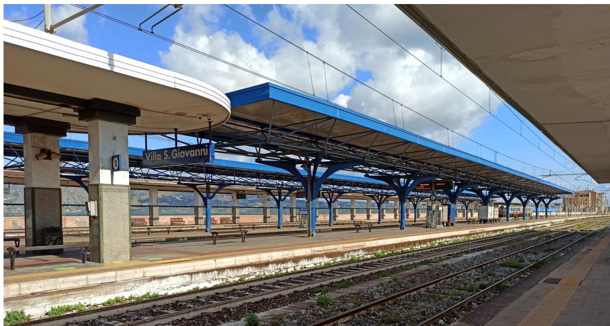
Figura 22 - le pensiline in acciaio a prolungamento delle pensiline storiche
