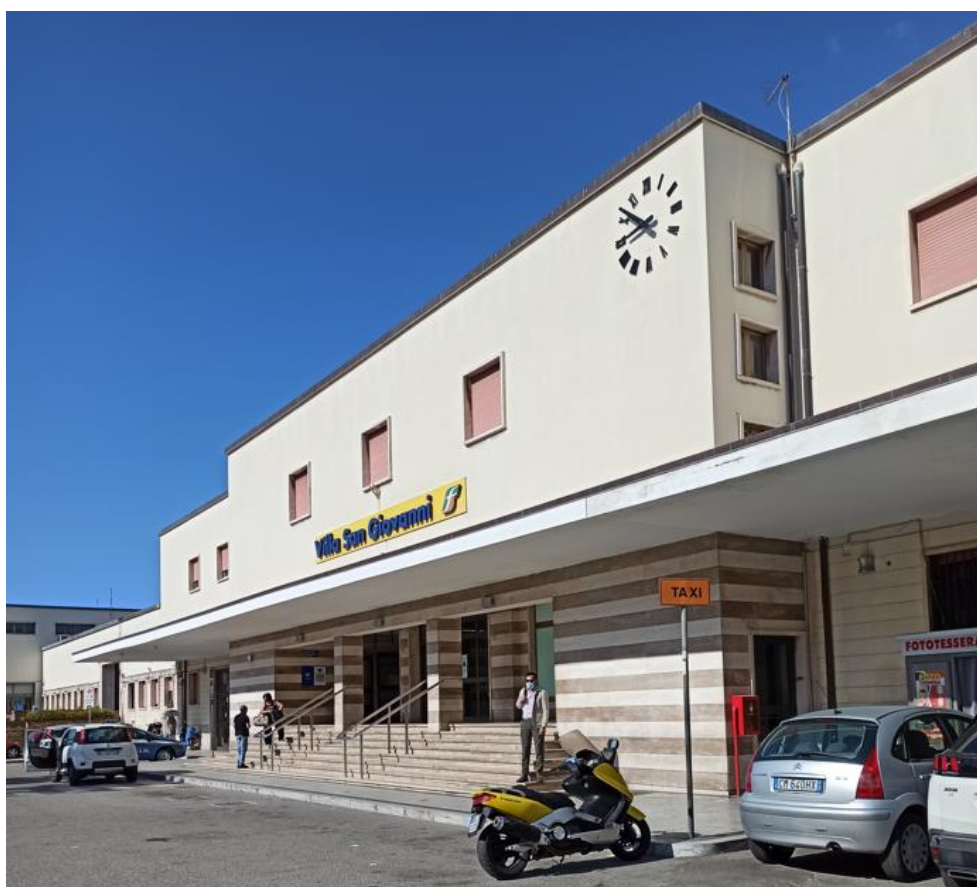
Figura 17 - Il corpo centrale in corrispondenza dell'accesso
