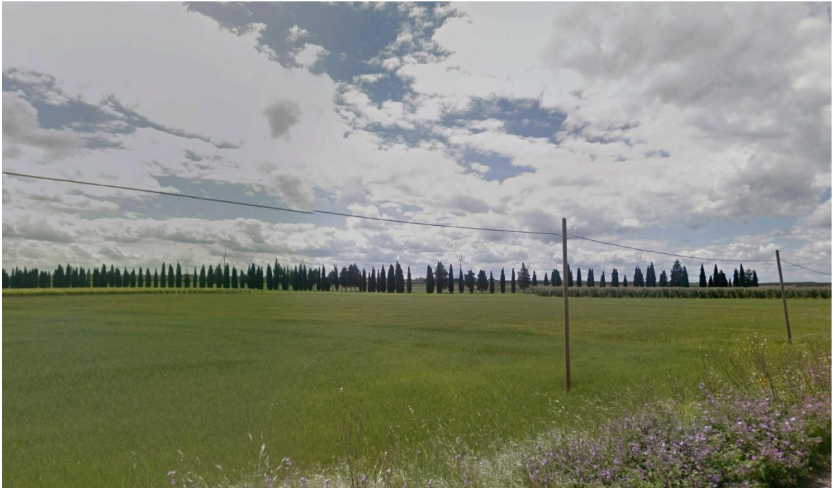
Figura 7.10: Sottostazione Elettrica interna all'impianto – Stato di Fatto
