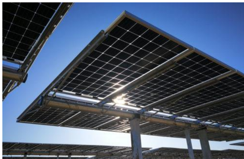
Figura 3.3 Esempio di struttura a tracker monoassiale
