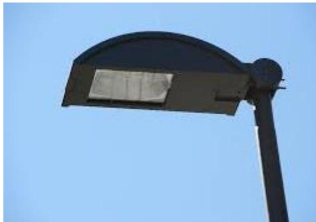
Figura 4.39: Esempio di apparecchio completamente schermato (full-cut-off).
