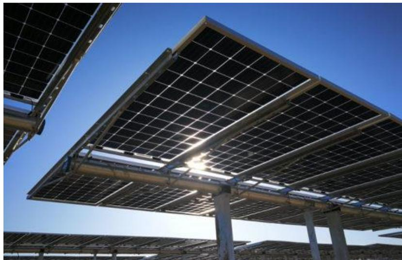
Figura 2.36 Esempio di struttura a tracker monoassiale
