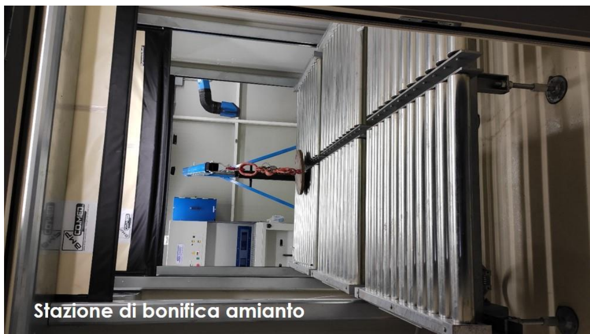
Stazione di taglio grandi componenti
